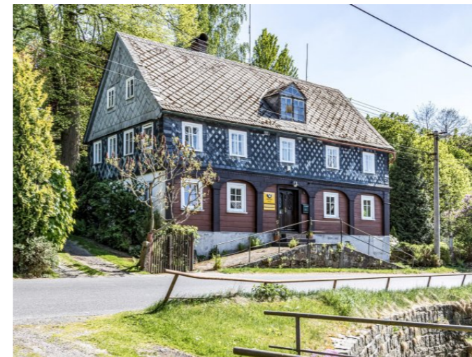
Brtníky č. p. 109 - Pohled na objekt ze severu (Zdroj: S. Šulcová, 2018)
