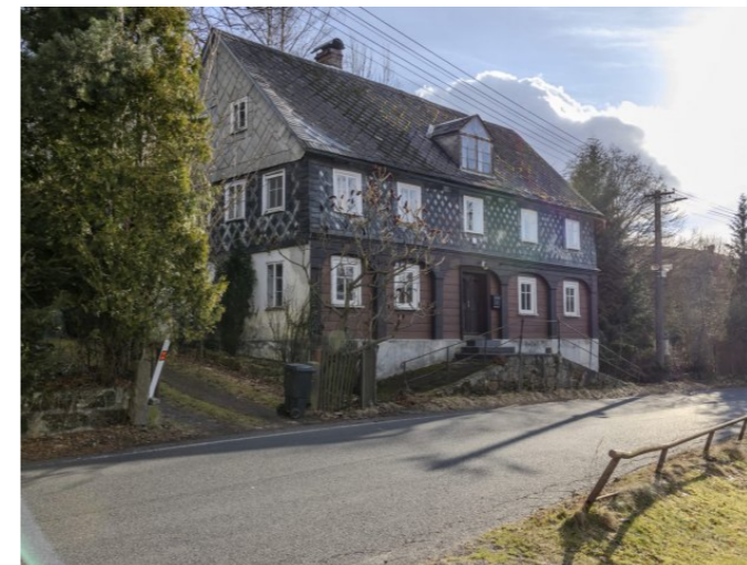
Brtníky č. p. 109 - Pohled na objekt ze severu (Zdroj: S. Šulcová, 2024)
