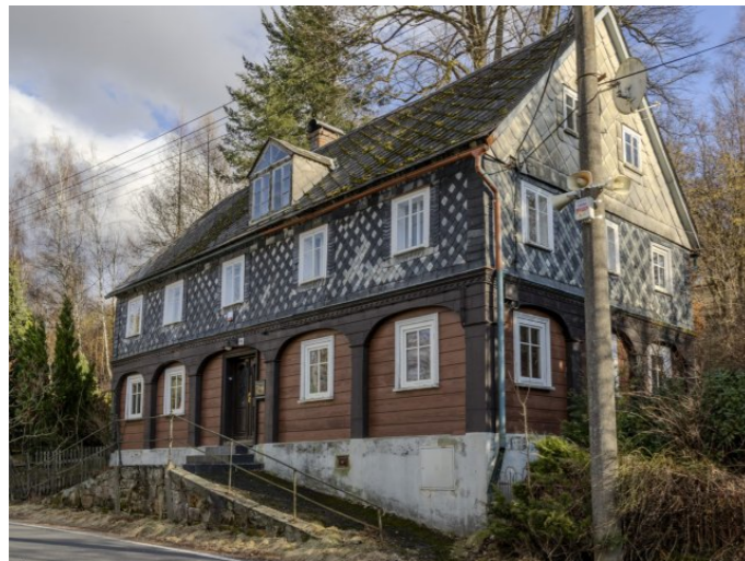
Brtníky č. p. 109 - Pohled na objekt ze západu (Zdroj: S. Šulcová, 2024)
