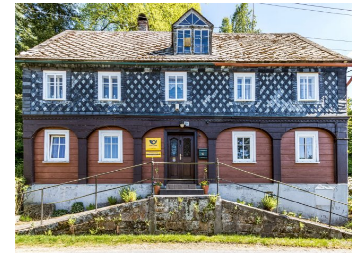
Brtníky č. p. 109 - Pohled na objekt ze severozápadu (Zdroj: S. Šulcová, 2018)
