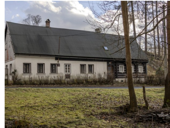
Brtníky č. p. 112 - Pohled na objekt ze severu (Zdroj: S. Šulcová, 2024)
