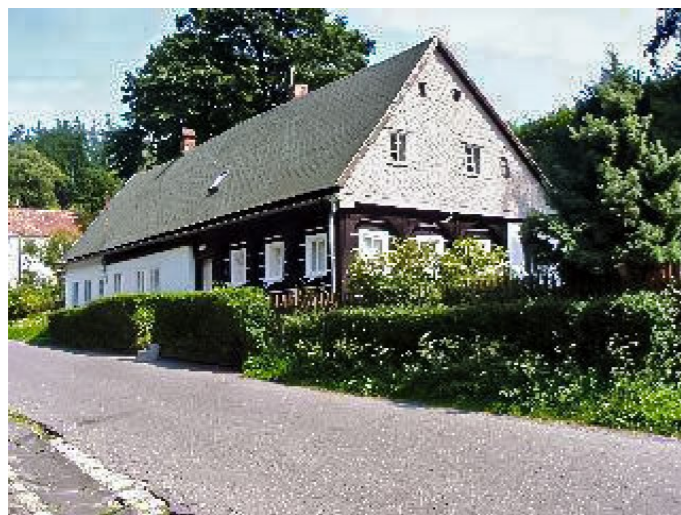
Brtníky č. p. 112 - Pohled na objekt ze západu (Zdroj: TUR Šluknovsko, 2003)
