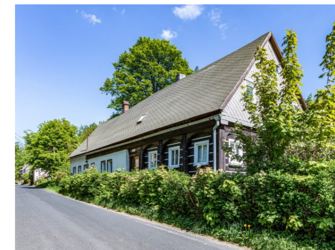
Brtníky č. p. 112 - Pohled na objekt ze severozápadu (Zdroj: S. Šulcová, 2018)
