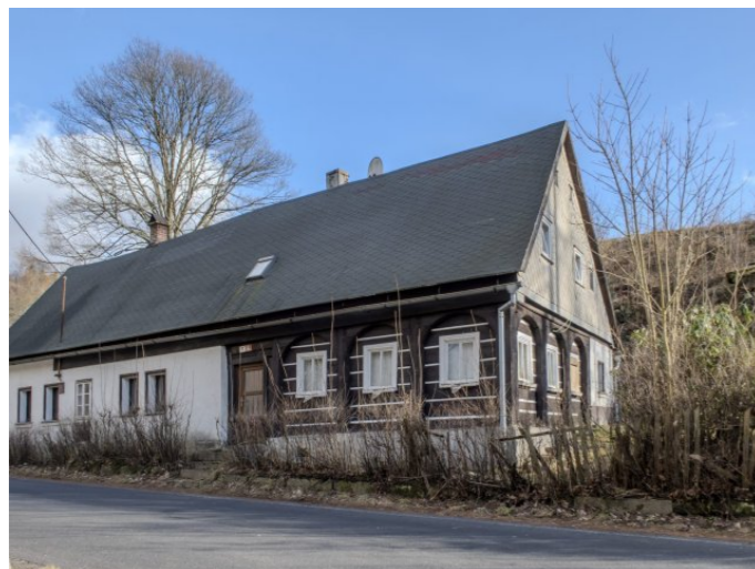
Brtníky č. p. 112 - Pohled na objekt ze severozápadu (Zdroj: S. Šulcová, 2024)
