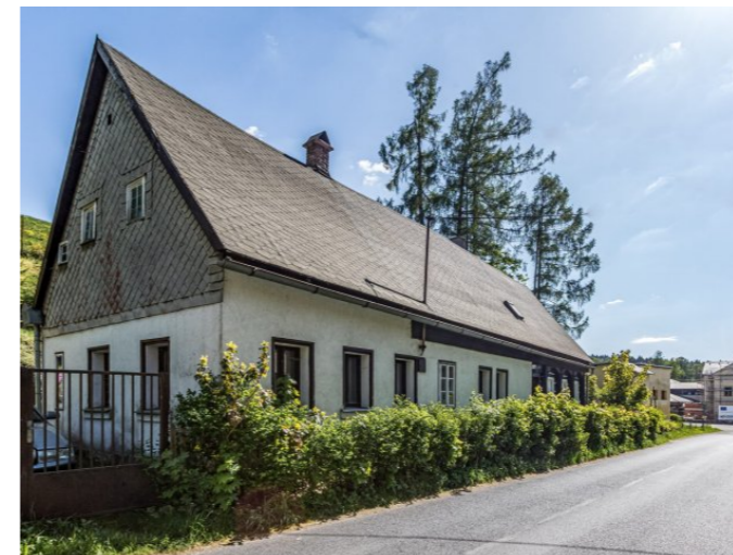
Brtníky č. p. 112 - Pohled na objekt ze severu (Zdroj: S. Šulcová, 2018)
