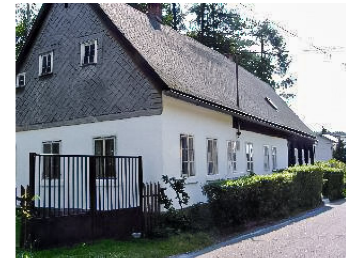
Brtníky č. p. 112 - Pohled na objekt ze severu (Zdroj: TUR Šluknovsko, 2003)
