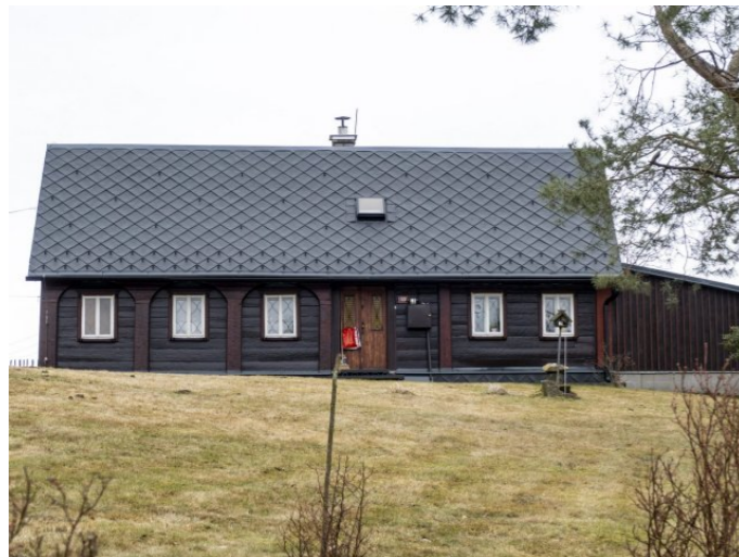
Brtníky č. p. 120 - Pohled na objekt ze západu (Zdroj: S. Šulcová, 2024)
