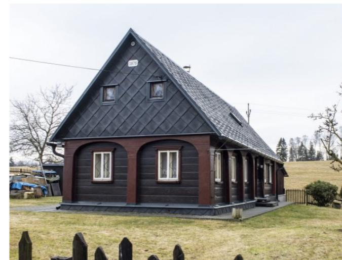
Brtníky č. p. 120 - Pohled na objekt ze severu (Zdroj: S. Šulcová, 2024)
