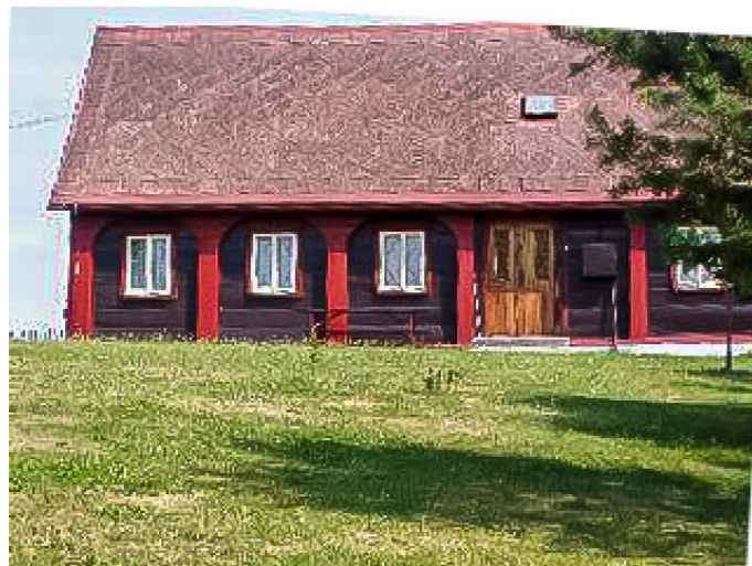
Brtníky č. p. 120 - Pohled na objekt ze západu (Zdroj: TUR Šluknovsko, 2003)
