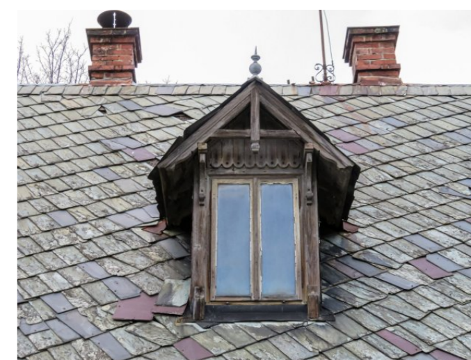
Brtníky č. p. 132 - Střešní vikýř se sedlovou střechou (Zdroj: S. Šulcová, 2018)
