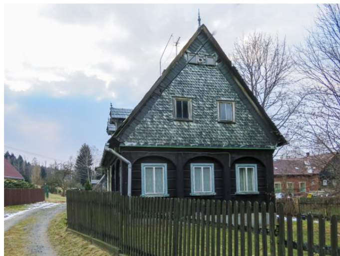
Brtníky č. p. 132 - Pohled na objekt z východu (Zdroj: S. Šulcová, 2018)
