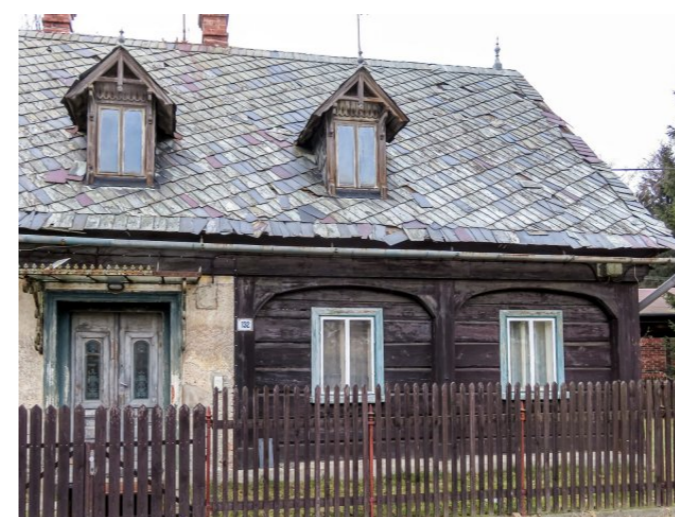
Brtníky č. p. 132 - Detail na podstávkovou část (Zdroj: S. Šulcová, 2018)
