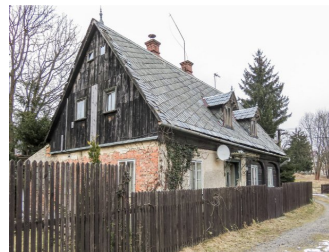
Brtníky č. p. 132 - Pohled na objekt z jihovýchodu (Zdroj: S. Šulcová, 2018)
