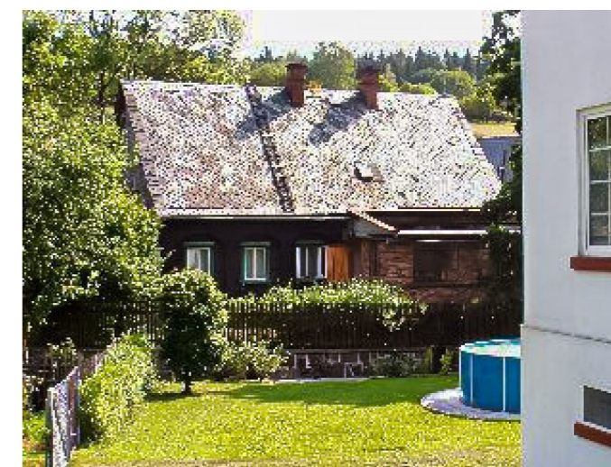
Brtníky č. p. 132 - Pohled na objekt ze severu (Zdroj: TUR Šluknovsko, 2003)
