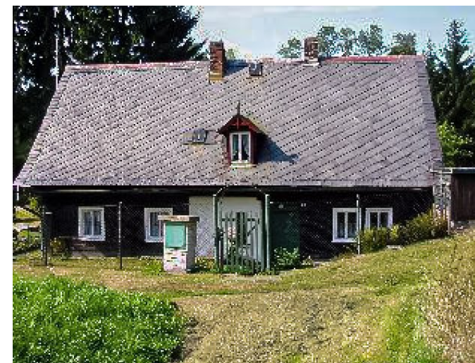
Brtníky č. p. 134 - Pohled na objekt z jihu (Zdroj: TUR Šluknovsko, 2003)
