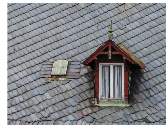
Brtníky č. p. 134 - Pohled na střešní vikýř (Zdroj: S. Šulcová, 2018)
