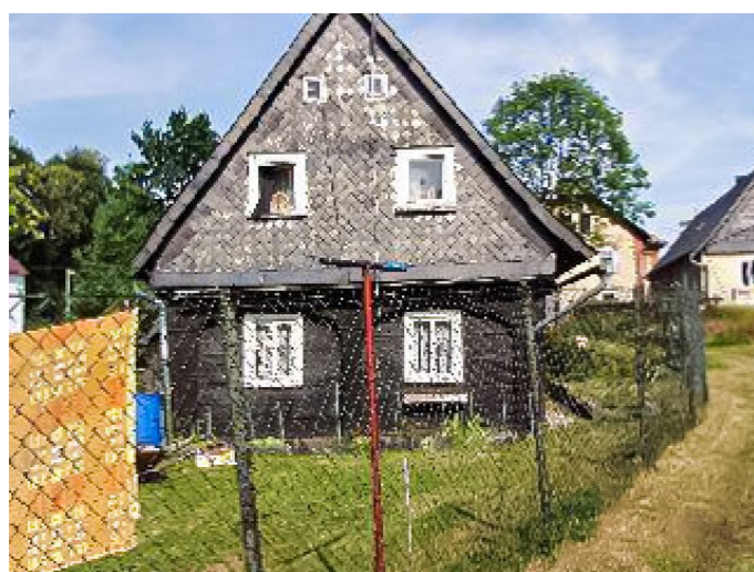
Brtníky č. p. 134 - Pohled na objekt ze západu (Zdroj: TUR Šluknovsko, 2003)
