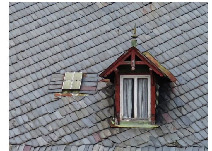
Brtníky č. p. 134 - Pohled na střešní vikýř (Zdroj: S. Šulcová, 2018)
