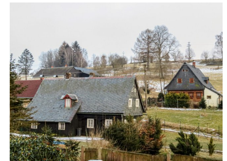
Brtníky č. p. 134 - Pohled na objekt ze severu (Zdroj: S. Šulcová, 2018)
