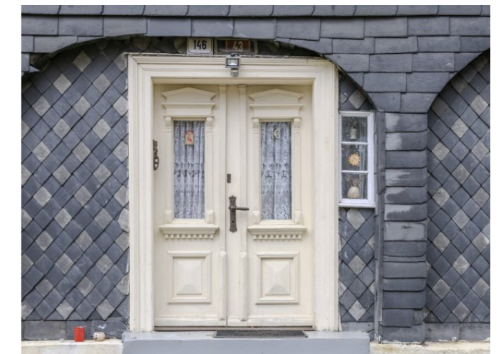
Brtníky č. p. 146 - Detail vstupního portálu (Zdroj: S. Šulcová, 2024)
