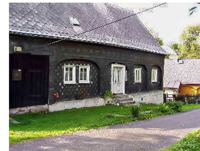
Brtníky č. p. 146 - Pohled na objekt z jihu (Zdroj: TUR Šluknovsko, 2003)
