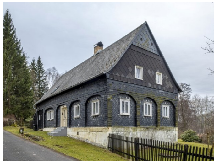
Brtníky č. p. 146 - Pohled na objekt z východu (Zdroj: S. Šulcová, 2024)
