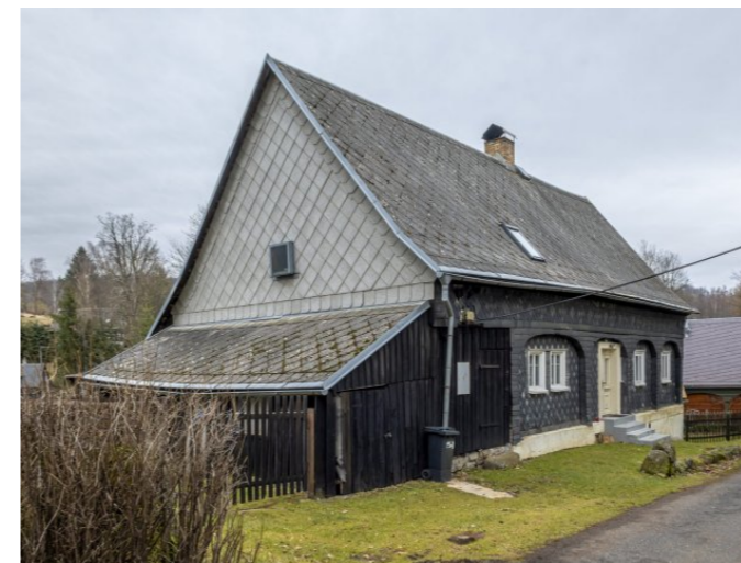
Brtníky č. p. 146 - Pohled na objekt z jihu (Zdroj: S. Šulcová, 2024)
