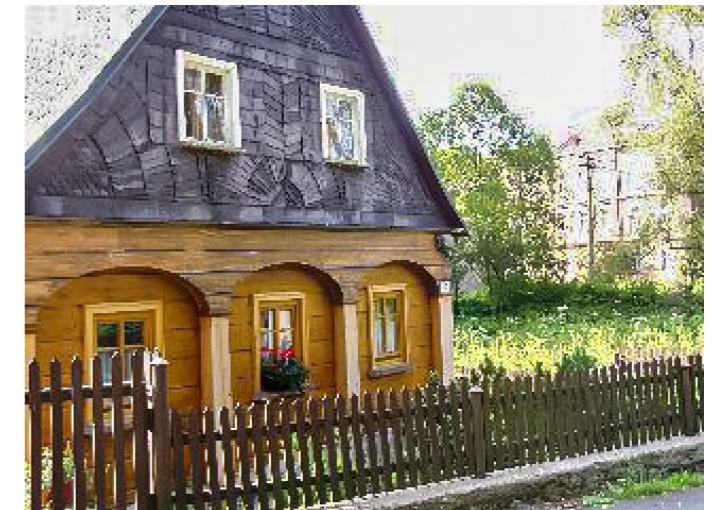
Brtníky č. p. 147 - Pohled na objekt z jihovýchodu (Zdroj: TUR Šluknovsko, 2003)
