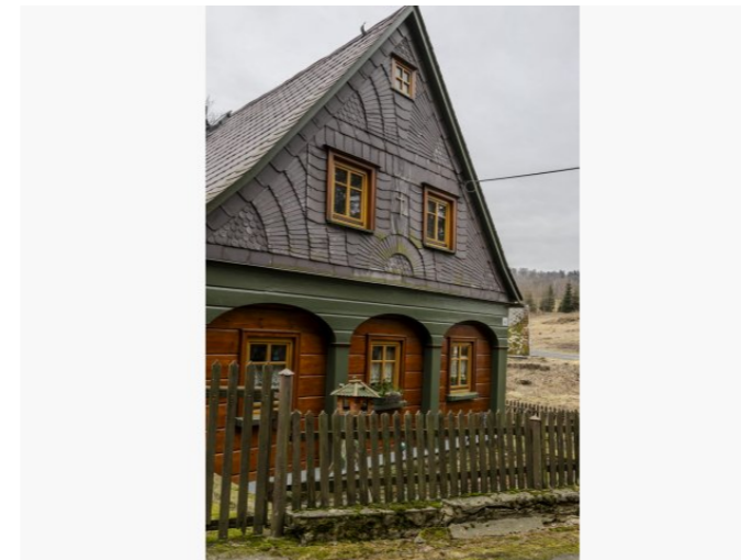
Brtníky č. p. 147 - Pohled na objekt z východu (Zdroj: S. Šulcová, 2024)
