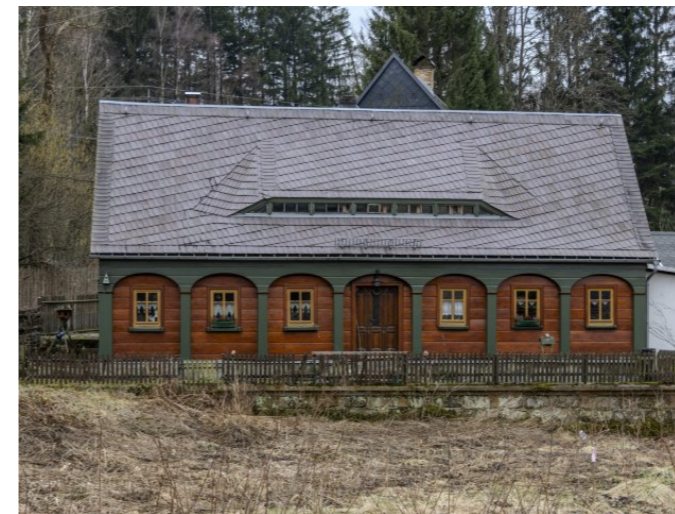
Brtníky č. p. 147 - Pohled na objekt ze severu (Zdroj: S. Šulcová, 2024)
