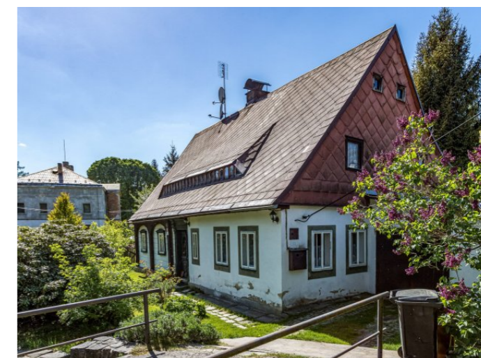
Brtníky č. p. 14 - Pohled na objekt z východu (Zdroj: S. Šulcová, 2018)
