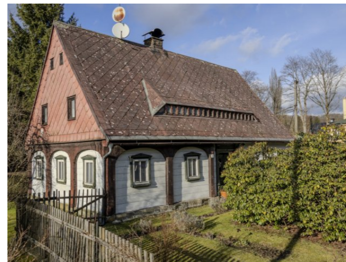
Brtníky č. p. 14 - Pohled na objekt z jihu (Zdroj: S. Šulcová, 2024)
