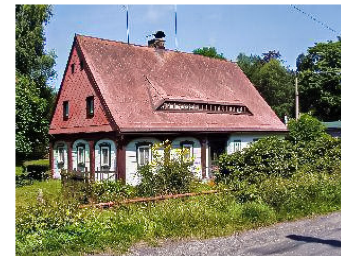
Brtníky č. p. 14 - Pohled na objekt z jihu (Zdroj: TUR Šluknovsko, 2003)
