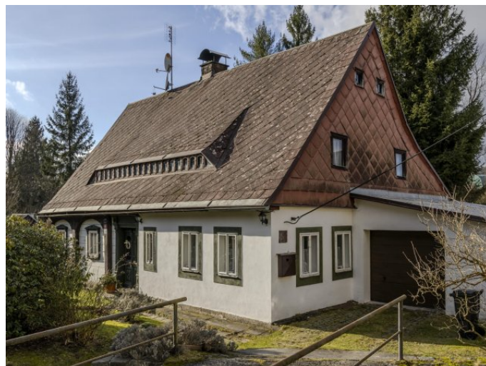
Brtníky č. p. 14 - Pohled na objekt z východu (Zdroj: S. Šulcová, 2024)
