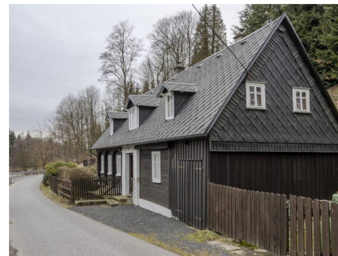
Brtníky č. p. 151 - Pohled na objekt z východu (Zdroj: S. Šulcová, 2024)
