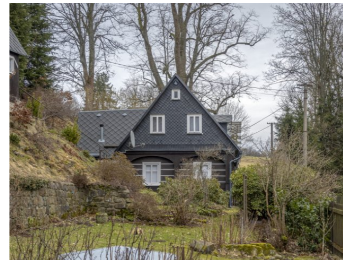
Brtníky č. p. 151 - Pohled na objekt ze západu (Zdroj: S. Šulcová, 2024)
