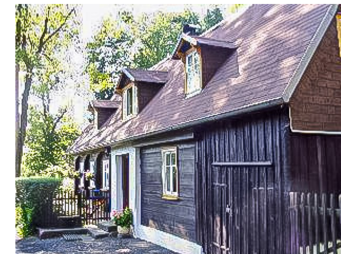
Brtníky č. p. 151 - Pohled na objekt z jihovýchodu (Zdroj: TUR Šluknovsko, 2003)
