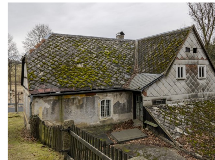
Brtníky č. p. 153 - Pohled na objekt ze severozápadu (Zdroj: S. Šulcová, 2024)
