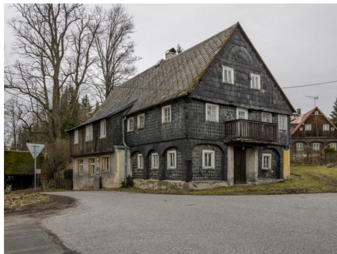
Brtníky č. p. 153 - Pohled na objekt z jihovýchodu (Zdroj: S. Šulcová, 2024)
