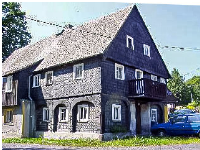
Brtníky č. p. 153 - Pohled na objekt z jihovýchodu (Zdroj: TUR Šluknovsko, 2003)
