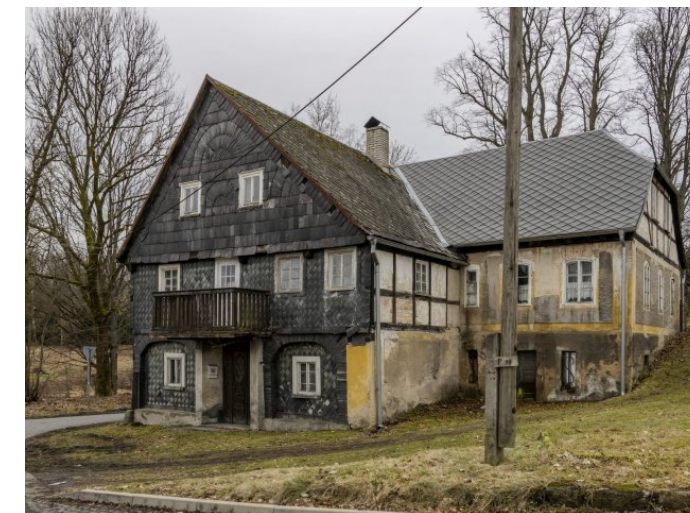
Brtníky č. p. 153 - Pohled na objekt ze severovýchodu (Zdroj: S. Šulcová, 2024)
