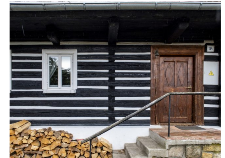
Brtníky č. p. 154 - Detail podstávkového pole s okenními otvory (Zdroj: S. Šulcová, 2024)
