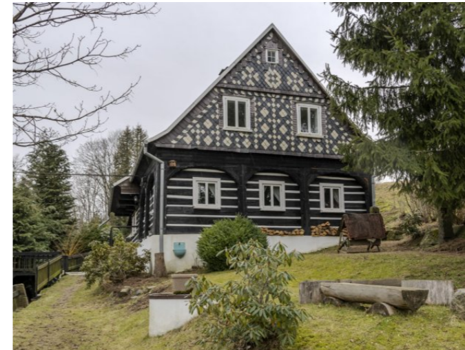
Brtníky č. p. 154 - Pohled na objekt z jihovýchodu (Zdroj: S. Šulcová, 2024)
