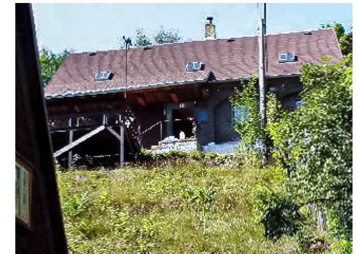
Brtníky č. p. 154 - Pohled na objekt z jihu (Zdroj: TUR Šluknovsko, 2003)
