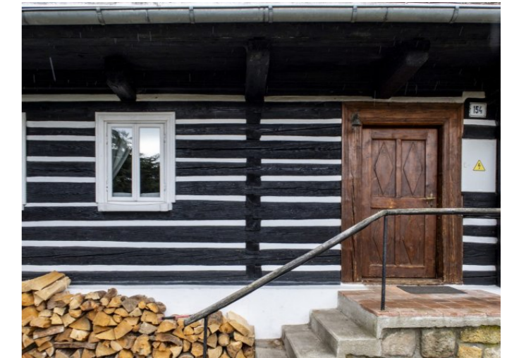
Brtníky č. p. 154 - Detail podstávkového pole s okenními otvory (Zdroj: S. Šulcová, 2024)
