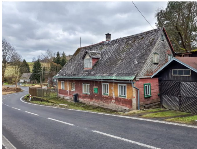
Brtníky č. p. 155 - Pohled na objekt ze severu (Zdroj: S. Šulcová, 2018)
