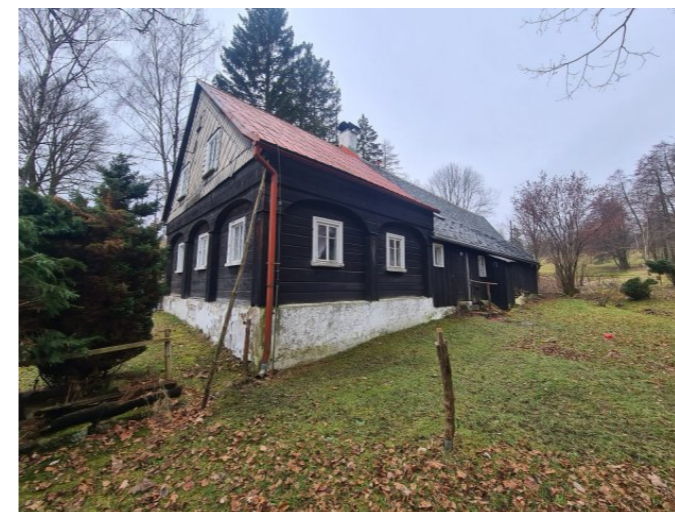
Brtníky č. p. 161 - Pohled na objekt z východu (Zdroj: S. Šulcová, 2024)
