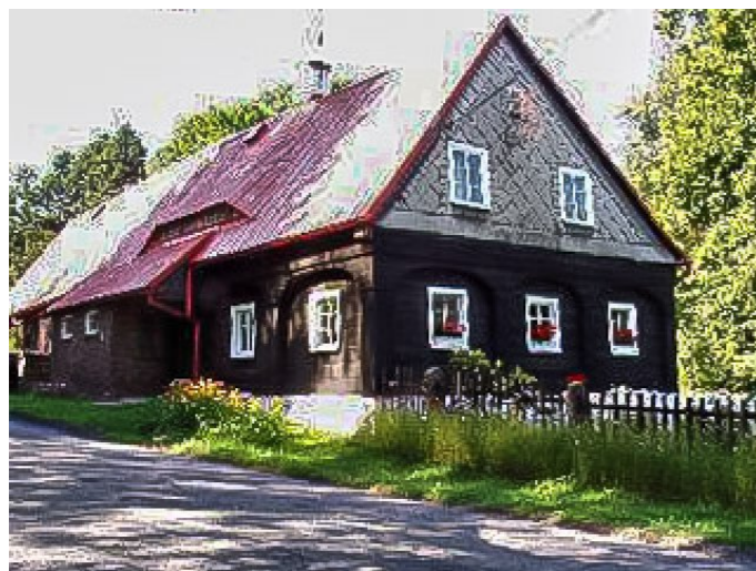
Brtníky č. p. 161 - Pohled na objekt z jihu (Zdroj: TUR Šluknovsko, 2003)
