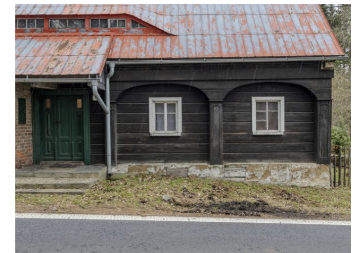
Brtníky č. p. 161 - Detail podstávkového pole s okenními otvory (Zdroj: S. Šulcová, 2024)
