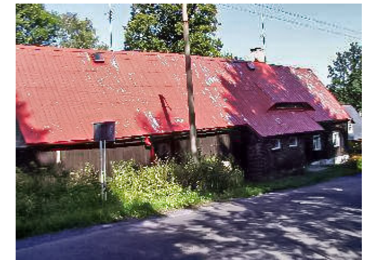
Brtníky č. p. 161 - Pohled na objekt ze západu (Zdroj: TUR Šluknovsko, 2003)
