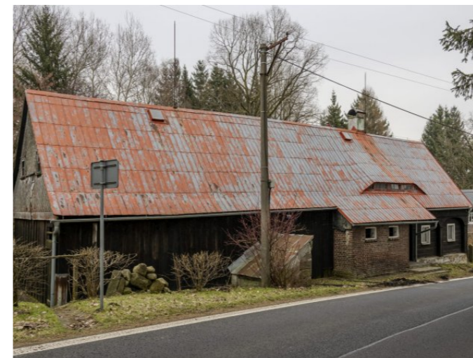
Brtníky č. p. 161 - Pohled na objekt ze západu (Zdroj: S. Šulcová, 2024)
