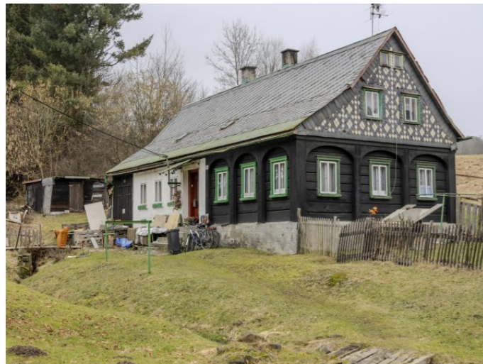
Brtníky č. p. 167 - Pohled na objekt z jihu (Zdroj: S. Šulcová, 2024)
