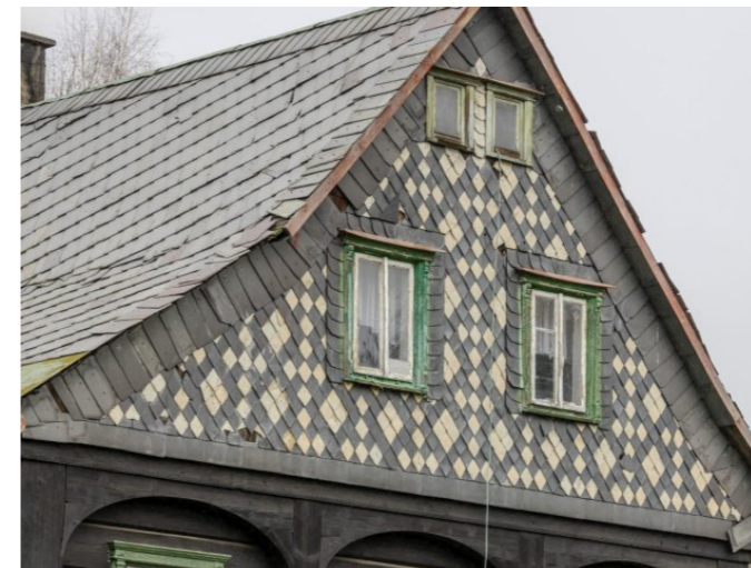
Brtníky č. p. 167 - Detail průčelí (Zdroj: S. Šulcová, 2024)
