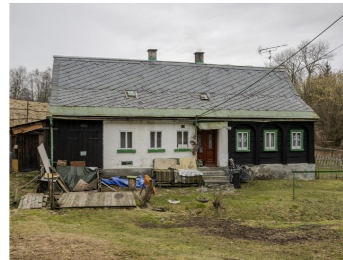
Brtníky č. p. 167 - Pohled na objekt z jihozápadu (Zdroj: S. Šulcová, 2024)
