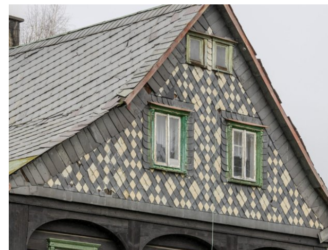
Brtníky č. p. 167 - Detail průčelí (Zdroj: S. Šulcová, 2024)
