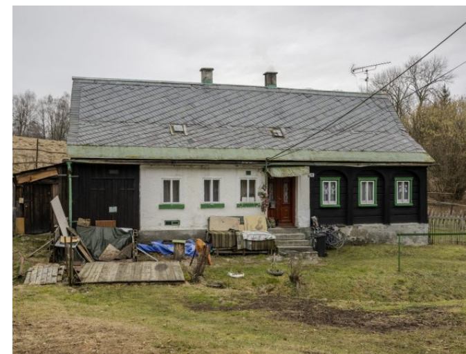
Brtníky č. p. 167 - Pohled na objekt z jihozápadu (Zdroj: S. Šulcová, 2024)
