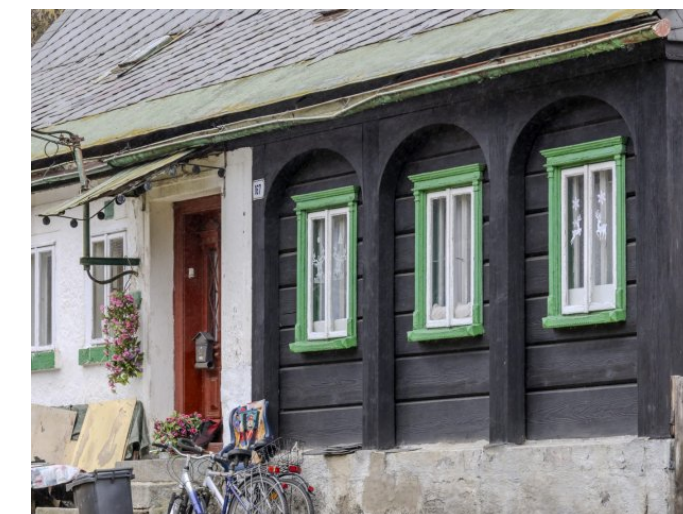
Brtníky č. p. 167 - Pohled na vstupní část (Zdroj: S. Šulcová, 2024)
