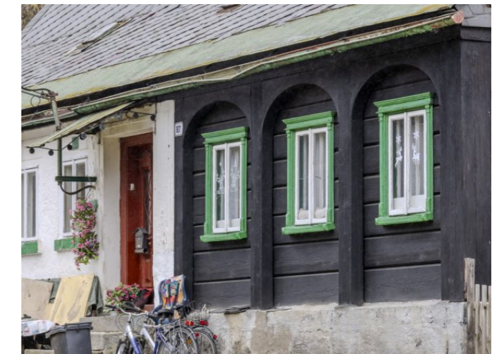
Brtníky č. p. 167 - Pohled na vstupní část (Zdroj: S. Šulcová, 2024)
