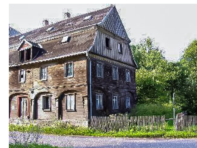
Brtníky č. p. 176 - Pohled na objekt z jihu (Zdroj: TUR Šluknovsko, 2003)
