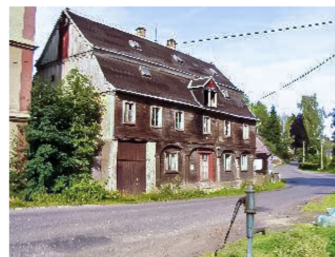
Brtníky č. p. 176 - Pohled na objekt z jihozápadu (Zdroj: TUR Šluknovsko, 2003)
