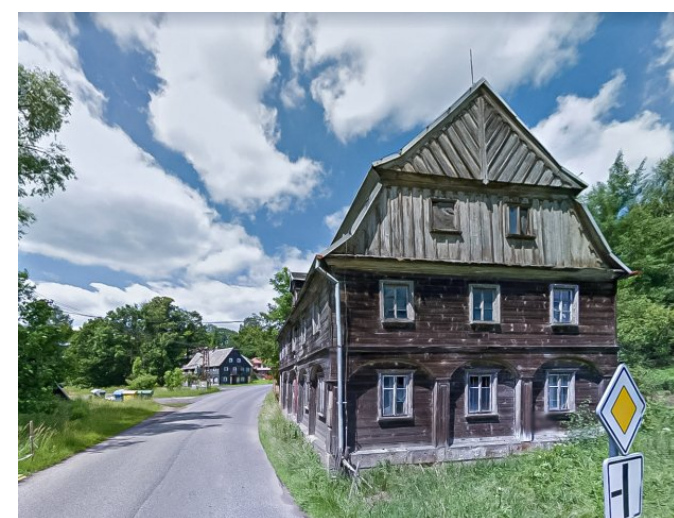
Brtníky č. p. 176 - Pohled na objekt z jihovýchodu (Zdroj: GOOGLÉ. [Brtníky 176]. Online. Google Maps, 2011., 2011)
