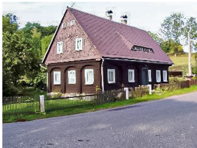
Brtníky č. p. 177 - Pohled na objekt z jihozápadu (Zdroj: TUR Šluknovsko, 2003)
