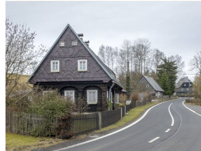
Brtníky č. p. 177 - Pohled na objekt z jihozápadu (Zdroj: S. Šulcová, 2024)
