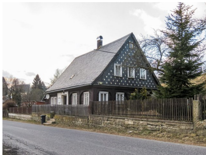
Brtníky č. p. 181 - Pohled na objekt z jihovýchodu (Zdroj: S. Šulcová, 2018)
