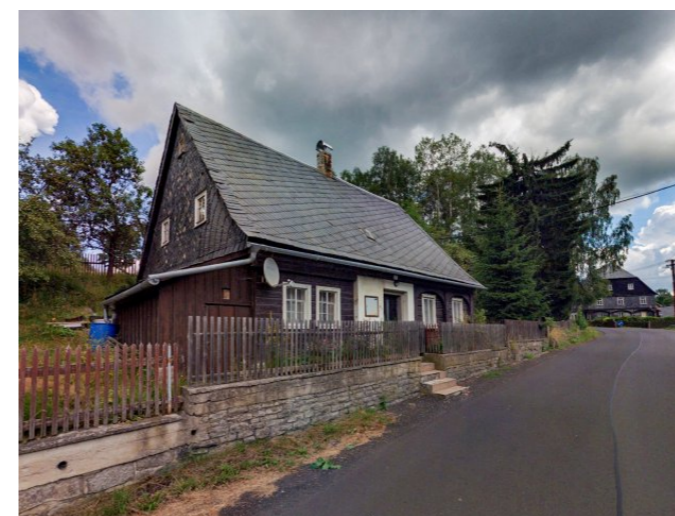
Brtníky č. p. 181 - Pohled na objekt z jihu (Zdroj: Mapy.cz, 2021)
