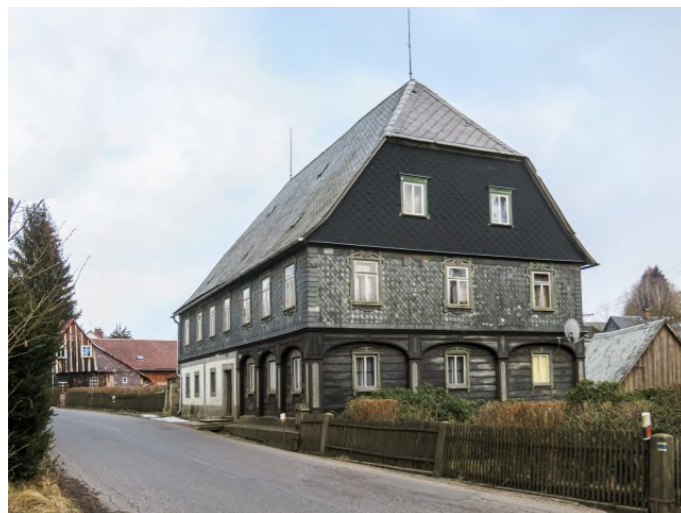
Brtníky č. p. 184 - Pohled na objekt ze severozápadu (Zdroj: S. Šulcová, 2018)
