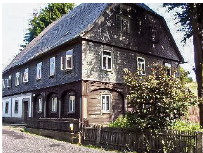
Brtníky č. p. 184 - Pohled na objekt ze severozápadu (Zdroj: TUR Šluknovsko, 2003)
