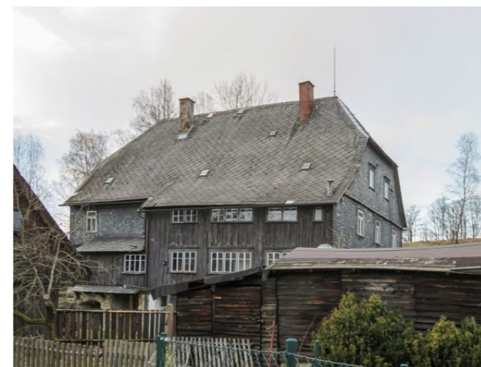
Brtníky č. p. 184 - Pohled na objekt z jihovýchodu (Zdroj: S. Šulcová, 2018)
