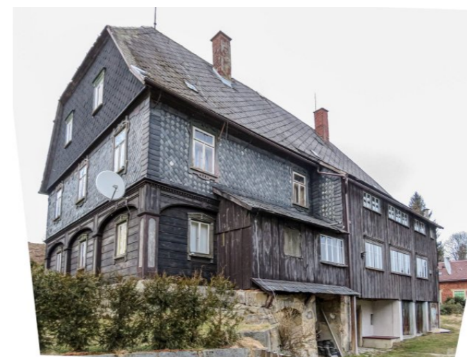
Brtníky č. p. 184 - Pohled na objekt z jihozápadu (Zdroj: S. Šulcová, 2018)
