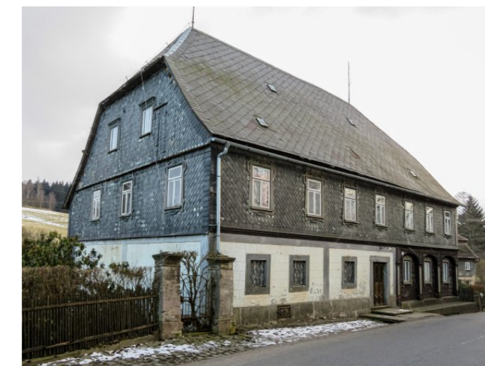
Brtníky č. p. 184 - Pohled na objekt ze severu (Zdroj: S. Šulcová, 2018)
