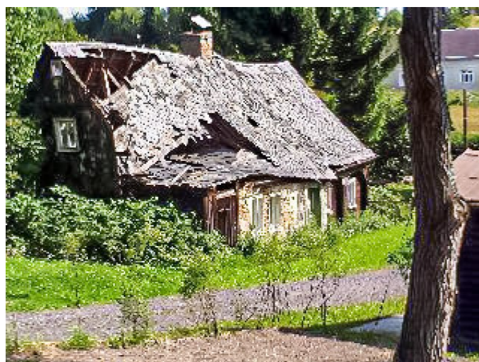
Brtníky č. p. 188 - Pohled na objekt ze severu (Zdroj: TUR Šluknovsko, 2003)
