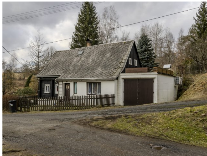
Brtníky č. p. 199 - Pohled na objekt z jihovýchodu (Zdroj: S. Šulcová, 2024)
