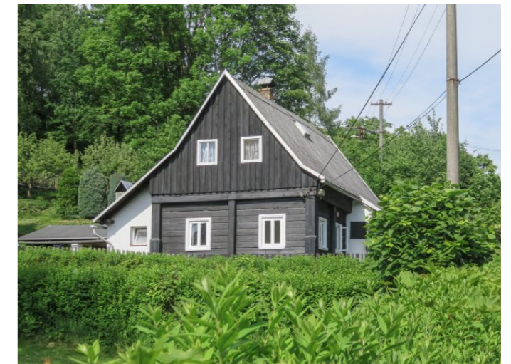
Brtníky č. p. 199 - Pohled na objekt ze západu (Zdroj: S. Šulcová, 2018)
