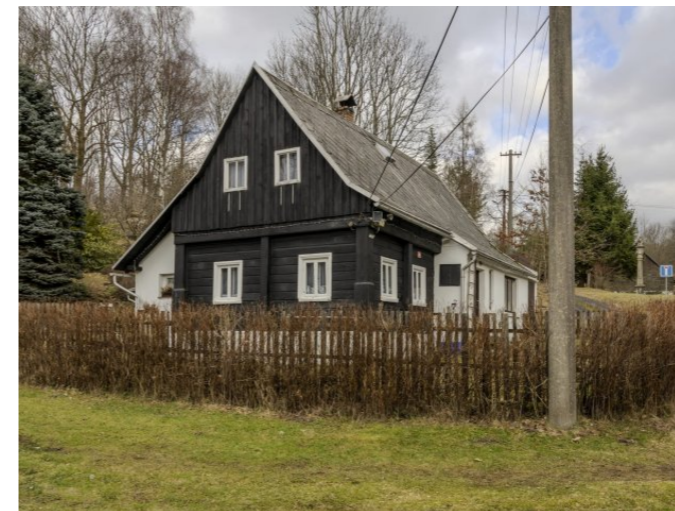
Brtníky č. p. 199 - Pohled na objekt z jihozápadu (Zdroj: S. Šulcová, 2024)
