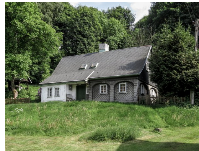
Brtníky č. p. 202 - Pohled na objekt ze severu (Zdroj: S. Šulcová, 2018)
