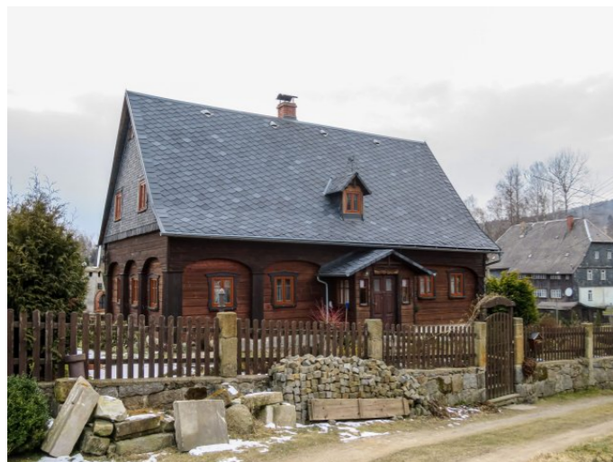
Brtníky č. p. 204 - Pohled na objekt z východu (Zdroj: S. Šulcová, 2018)
