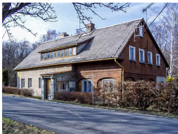
Brtníky č. p. 205 - Pohled na objekt z jihovýchodu (Zdroj: TUR Šluknovsko, 2003)
