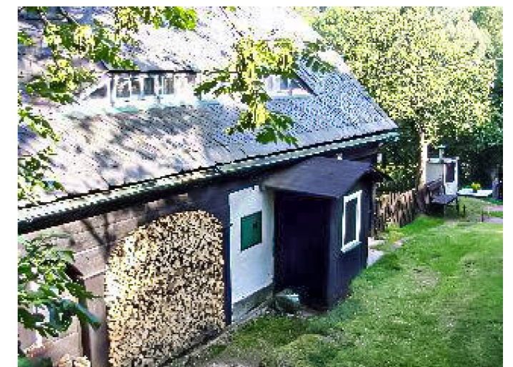
Brtníky č. p. 208 - Pohled na objekt z jihu (Zdroj: TUR Šluknovsko, 2003)
