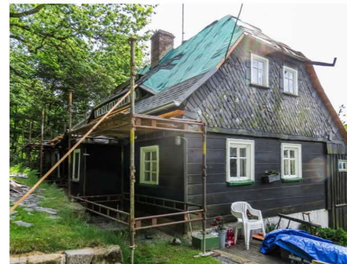
Brtníky č. p. 208 - Pohled na objekt ze severovýchodu (Zdroj: S. Šulcová, 2018)
