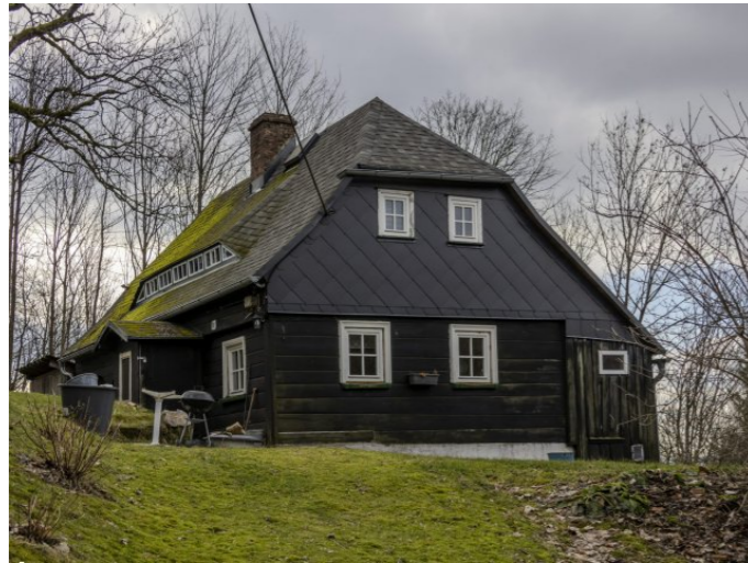
Brtníky č. p. 208 - Pohled na objekt ze severovýchodu (Zdroj: S. Šulcová, 2024)
