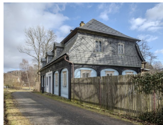
Brtníky č. p. 210 - Pohled na objekt ze západu (Zdroj: S. Šulcová, 2024)
