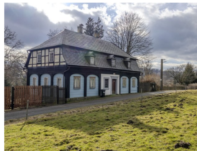
Brtníky č. p. 210 - Pohled na objekt ze severu (Zdroj: S. Šulcová, 2024)
