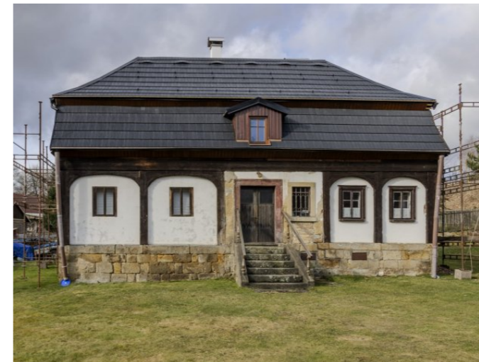
Brtníky č. p. 211 - Pohled na objekt z jihovýchodu (Zdroj: S. Šulcová, 2024)
