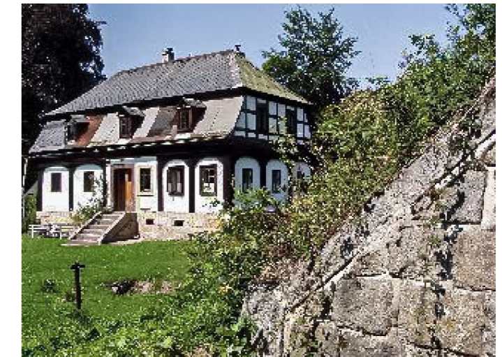
Brtníky č. p. 211 - Pohled na objekt z jihovýchodu (Zdroj: TUR Šluknovsko, 2003)
