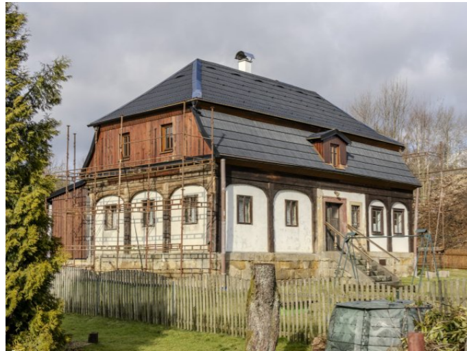
Brtníky č. p. 211 - Pohled na objekt z jihu (Zdroj: S. Šulcová, 2024)
