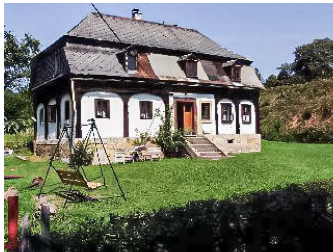
Brtníky č. p. 211 - Pohled na objekt z jihu (Zdroj: TUR Šluknovsko, 2003)
