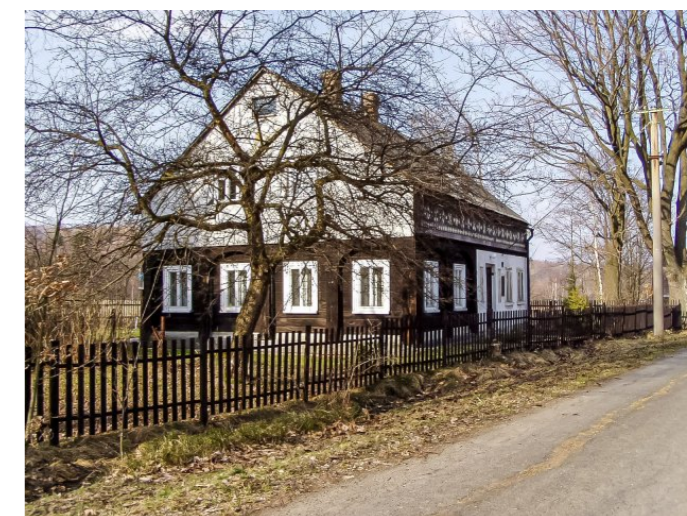
Brtníky č. p. 253 - Pohled na objekt z jihu (Zdroj: TUR Šluknovsko, 2003)
