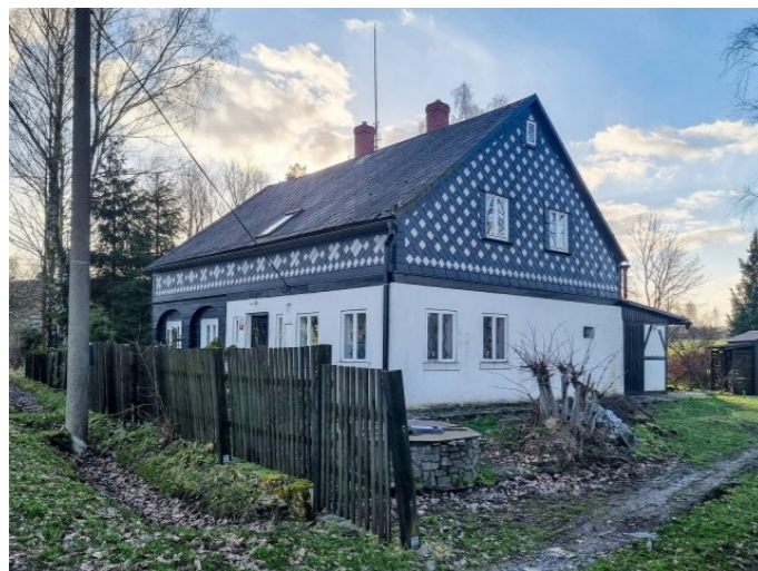
Brtníky č. p. 253 - Pohled na objekt z východu (Zdroj: S. Šulcová, 2024)
