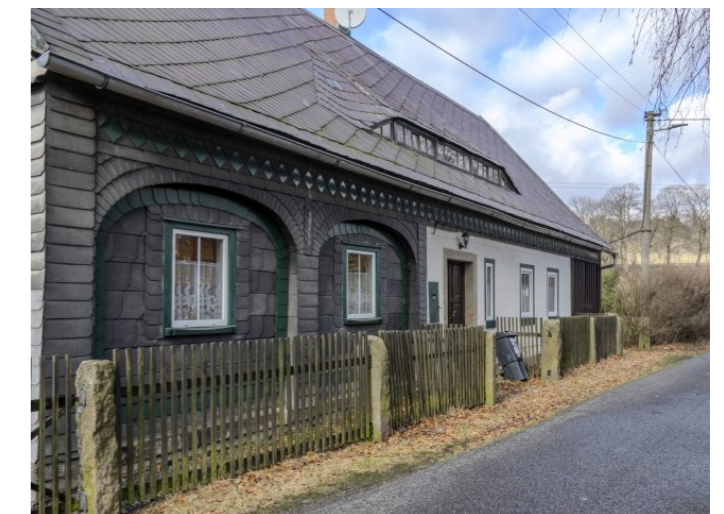
Brtníky č. p. 30 - Pohled na podstávkovou část (Zdroj: S. Šulcová, 2024)
