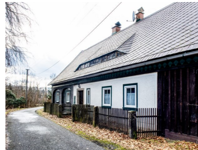
Brtníky č. p. 30 - Pohled na objekt (Zdroj: S. Šulcová, 2024)
