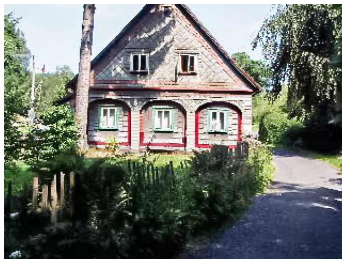
Brtníky č. p. 30 - Pohled na objekt z jihu (Zdroj: TUR Šluknovsko, 2003)
