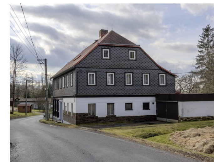
Brtníky č. p. 49 - Pohled na objekt ze severovýchodu (Zdroj: S. Šulcová, 2024)
