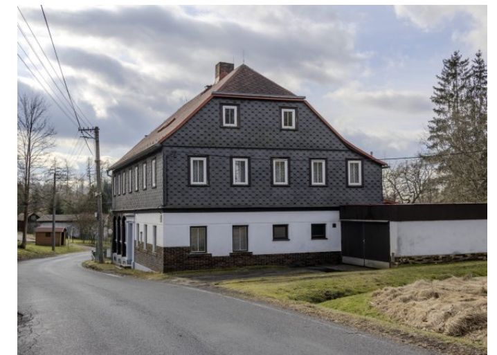
Brtníky č. p. 49 - Pohled na objekt ze severovýchodu (Zdroj: S. Šulcová, 2024)
