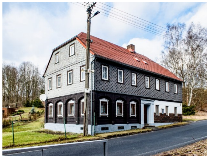
Brtníky č. p. 49 - Pohled na objekt z jihu (Zdroj: S. Šulcová, 2024)
