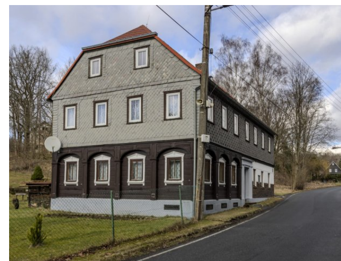
Brtníky č. p. 49 - Pohled na objekt z jihu (Zdroj: S. Šulcová, 2018)
