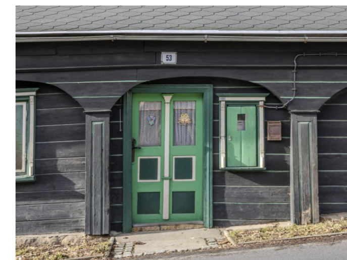
Brtníky č. p. 53 - Detail vstupního portálu (Zdroj: S. Šulcová, 2024)
