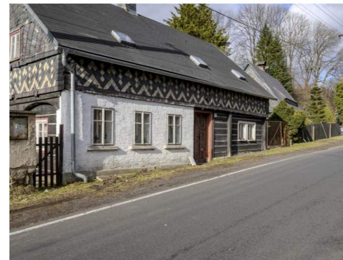
Brtníky č. p. 54 - Pohled na vstupní část (Zdroj: S. Šulcová, 2024)
