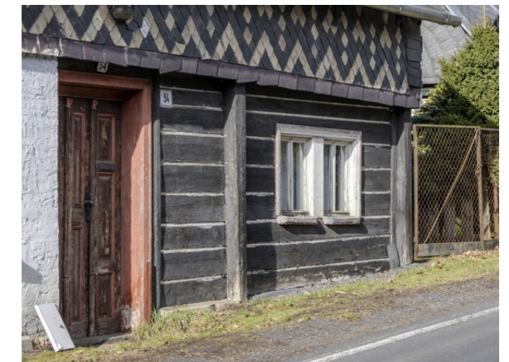
Brtníky č. p. 54 - Pohled na podstávkovou část (Zdroj: S. Šulcová, 2024)
