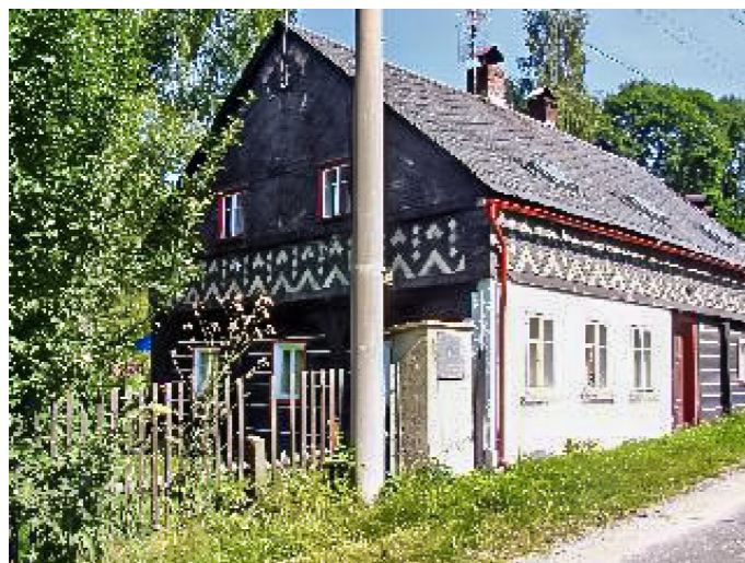
Brtníky č. p. 54 - Pohled na objekt z jihu (Zdroj: TUR Šluknovsko, 2003)
