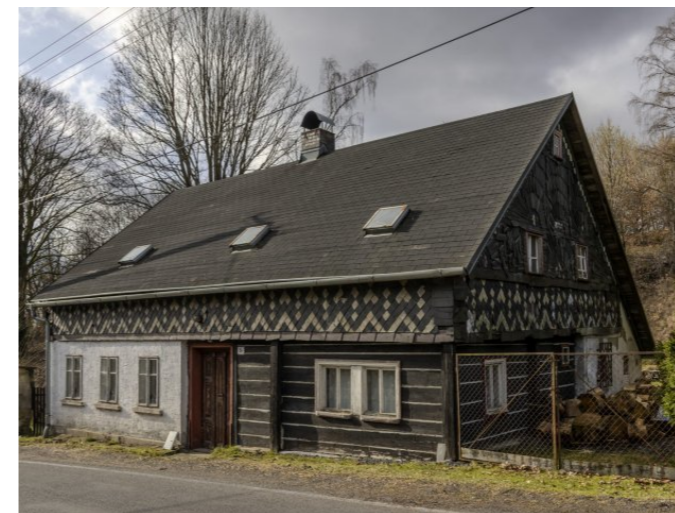
Brtníky č. p. 54 - Pohled na objekt z východu (Zdroj: S. Šulcová, 2024)
