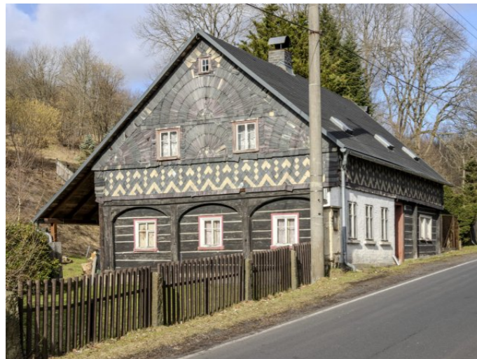
Brtníky č. p. 54 - Pohled na objekt z jihu (Zdroj: S. Šulcová, 2024)
