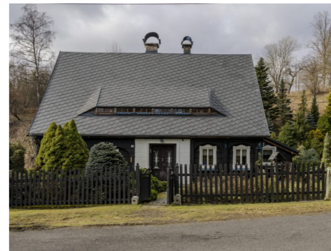
Brtníky č. p. 55 - Pohled na vstupní část (Zdroj: S. Šulcová, 2024)
