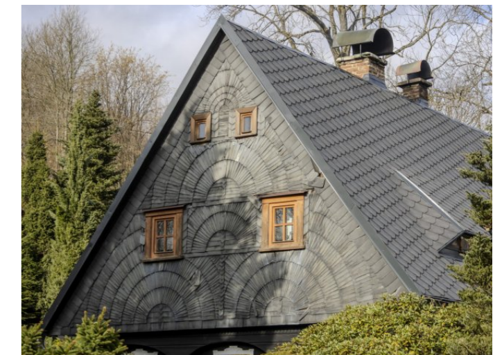
Brtníky č. p. 55 - Detail průčelí (Zdroj: S. Šulcová, 2024)
