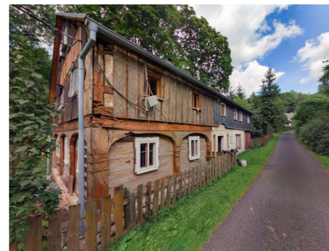
Brtníky č. p. 58 - Pohled na objekt z jihovýchodu (Zdroj: Mapy.cz, 2021)
