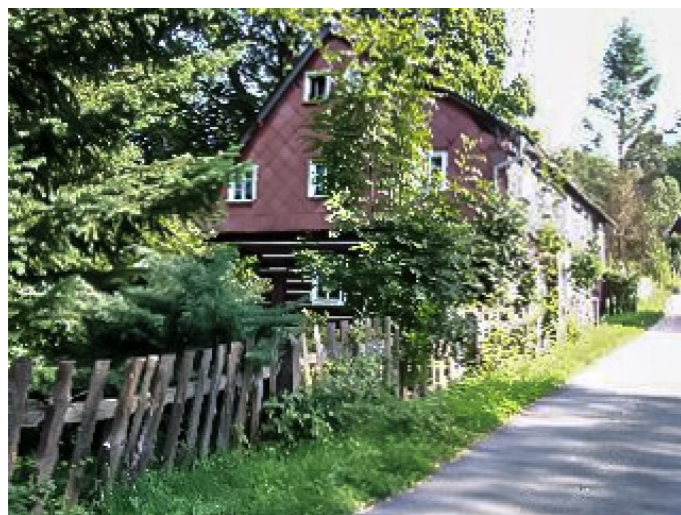
Brtníky č. p. 58 - Pohled na objekt z jihu (Zdroj: TUR Šluknovsko, 2003)
