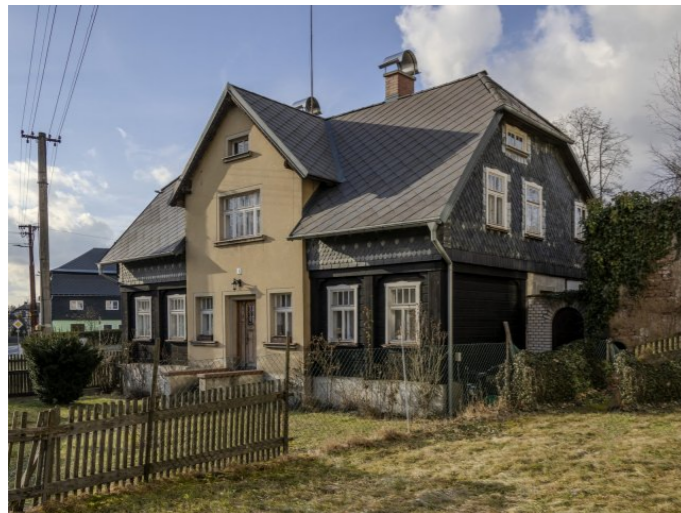
Brtníky č. p. 5 - Pohled na objekt z jihovýchodu (Zdroj: S. Šulcová, 2024)
