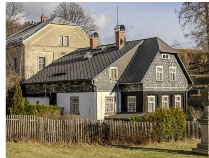
Brtníky č. p. 5 - Pohled na objekt ze západu (Zdroj: S. Šulcová, 2024)
