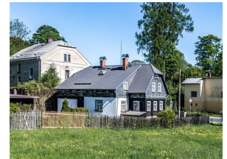
Brtníky č. p. 5 - Pohled na objekt ze severozápadu (Zdroj: S. Šulcová, 2018)
