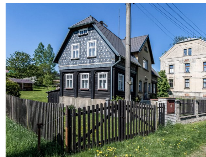
Brtníky č. p. 5 - Pohled na objekt z jihozápadu (Zdroj: S. Šulcová, 2018)
