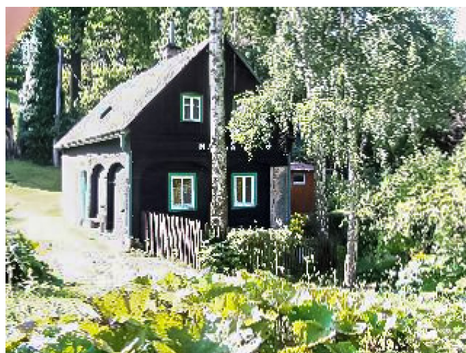
Brtníky č. p. 67 - Pohled na objekt ze severu (Zdroj: TUR Šluknovsko, 2003)
