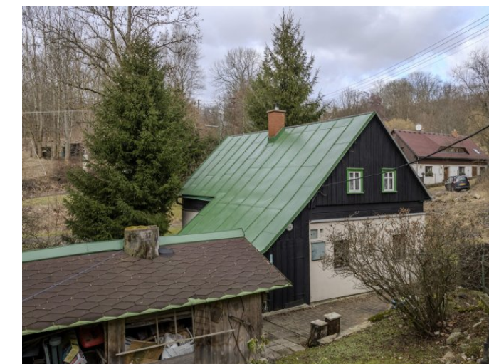
Brtníky č. p. 67 - Pohled na objekt z jihozápadu (Zdroj: S. Šulcová, 2024)
