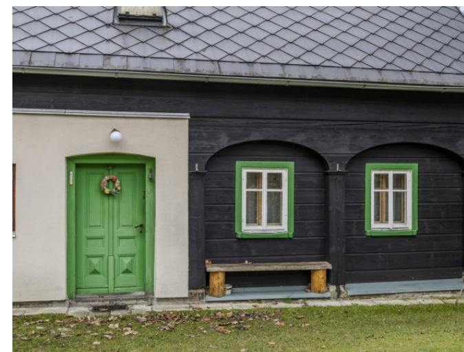
Brtníky č. p. 67 - Pohled na vstupní část (Zdroj: S. Šulcová, 2024)
