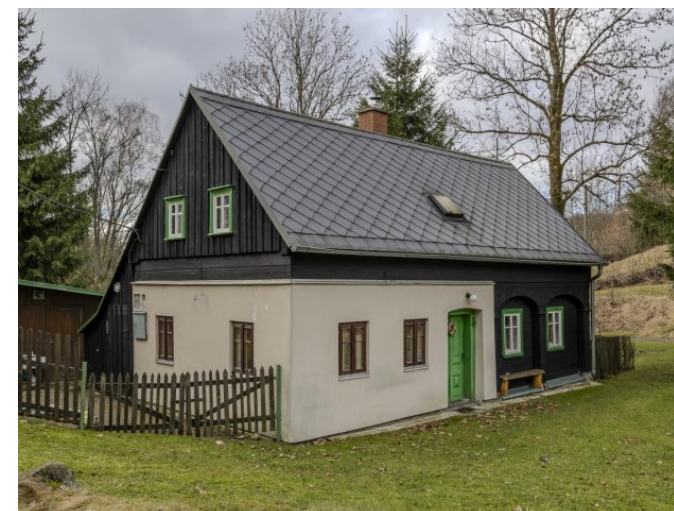
Brtníky č. p. 67 - Pohled na objekt z jihovýchodu (Zdroj: S. Šulcová, 2024)
