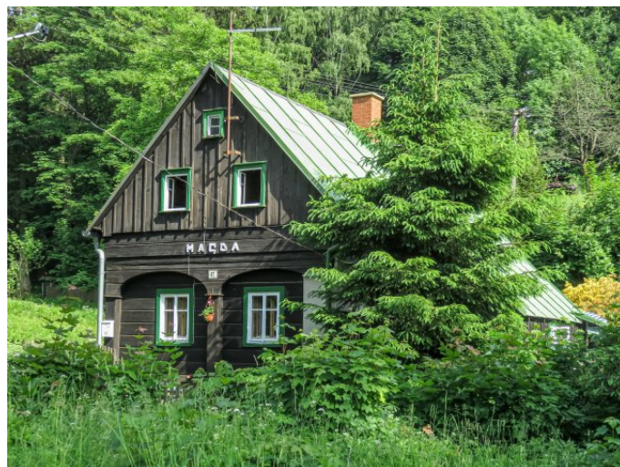
Brtníky č. p. 67 - Pohled na objekt ze severozápadu (Zdroj: S. Šulcová, 2018)
