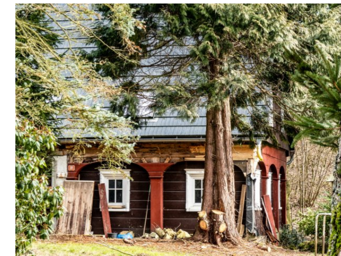
Brtníky č. p. 74 - Detail na západní nároží (Zdroj: S. Šulcová, 2024)
