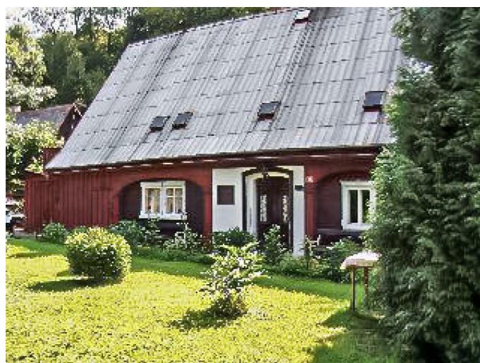
Brtníky č. p. 74 - Pohled na objekt ze západu (Zdroj: TUR Šluknovsko, 2003)
