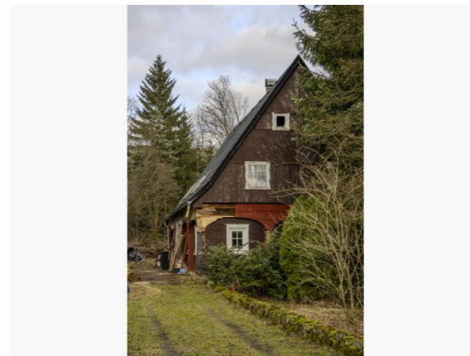
Brtníky č. p. 74 - Pohled na objekt z jihu (Zdroj: S. Šulcová, 2024)
