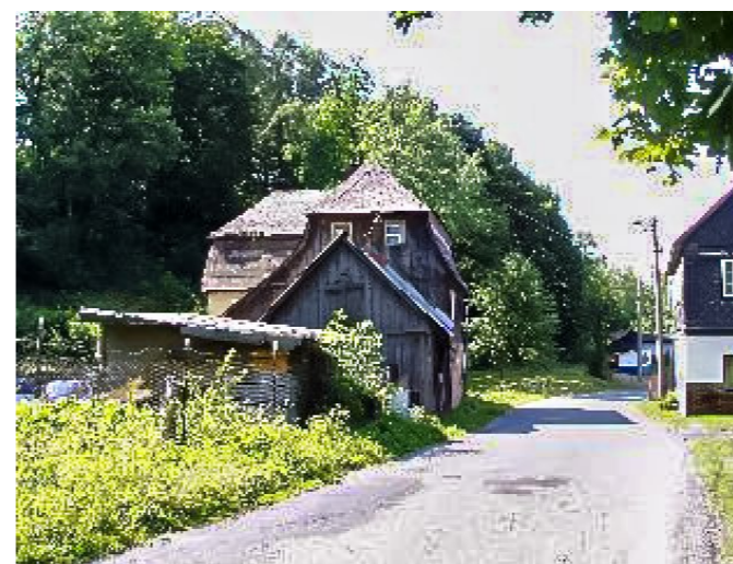
Brtníky č. p. 83 - Pohled na objekt ze severu (Zdroj: TUR Šluknovsko, 2003)
