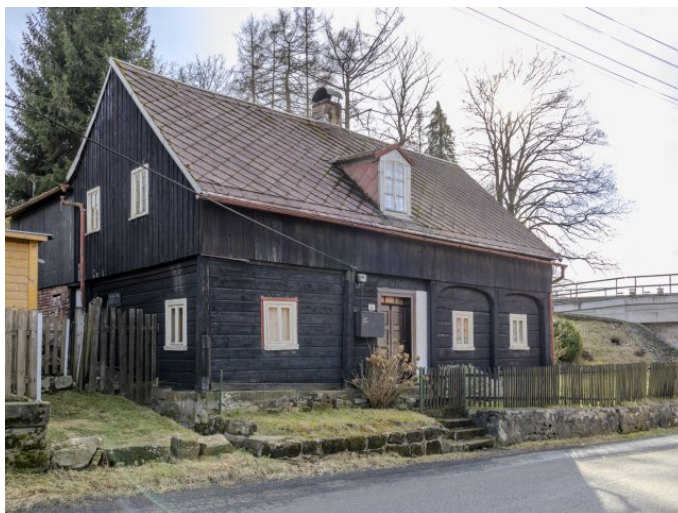
Brtníky č. p. 92 - Pohled na objekt ze severu (Zdroj: S. Šulcová, 2024)
