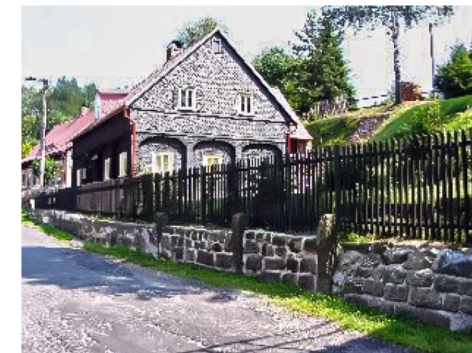
Brtníky č. p. 92 - Pohled na objekt ze západu (Zdroj: TUR Šluknovsko, 2003)
