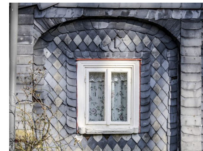
Brtníky č. p. 92 - Detail podstávkového pole s okenním otvorem (Zdroj: S. Šulcová, 2024)
