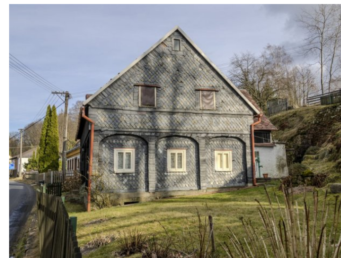
Brtníky č. p. 92 - Pohled na objekt ze západu (Zdroj: S. Šulcová, 2024)
