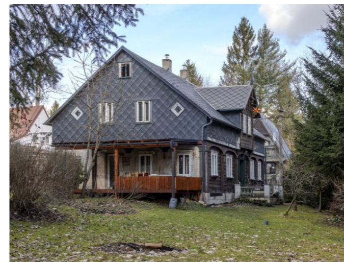
Brtníky č. p. 9 - Pohled na objekt ze západu (Zdroj: S. Šulcová, 2024)
