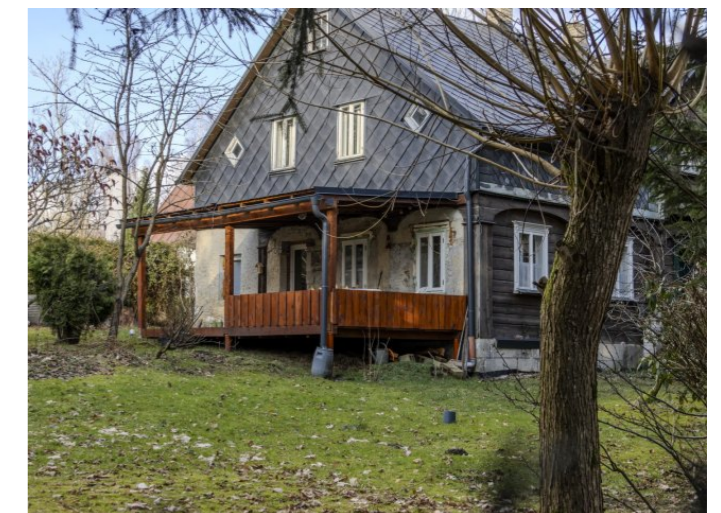
Brtníky č. p. 9 - Pohled na objekt z jihozápadu (Zdroj: S. Šulcová, 2024)
