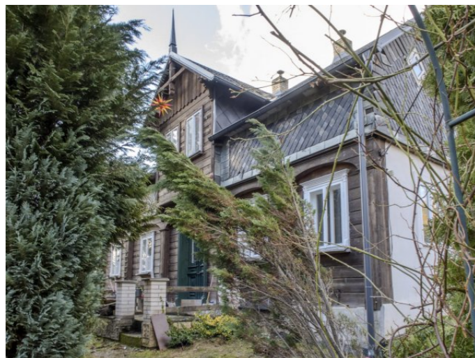
Brtníky č. p. 9 - Pohled na vstupní část (Zdroj: S. Šulcová, 2024)
