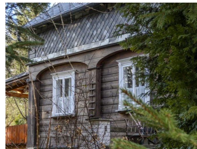
Brtníky č. p. 9 - Detail podstávkového pole s okenním otvorem (Zdroj: S. Šulcová, 2024)
