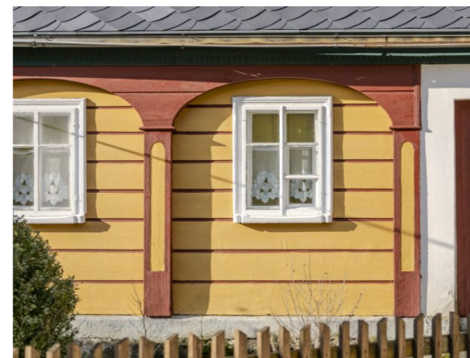
Brtníky č. ev. 21 - Detail podstávkového pole s okenními otvory (Zdroj: S. Šulcová, 2024)
