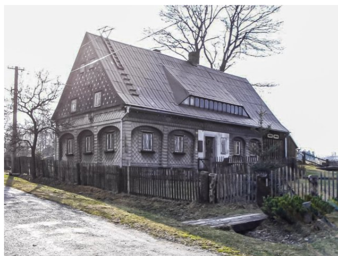
Brtníky č. ev. 23 - Pohled na objekt z východu (Zdroj: TUR Šluknovsko, 2003)
