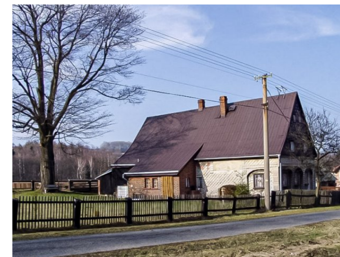
Brtníky č. ev. 23 - Pohled na objekt z jihu (Zdroj: TUR Šluknovsko, 2003)
