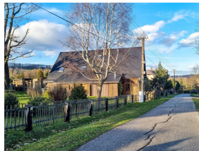
Brtníky č. ev. 23 - Pohled na objekt z jihu (Zdroj: S. Šulcová, 2024)
