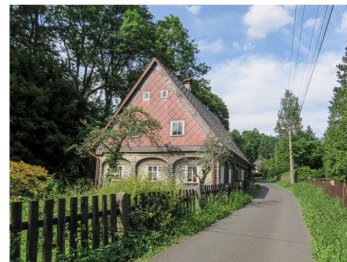
Brtníky č. ev. 28 - Pohled na objekt z jihozápadu (Zdroj: S. Šulcová, 2018)
