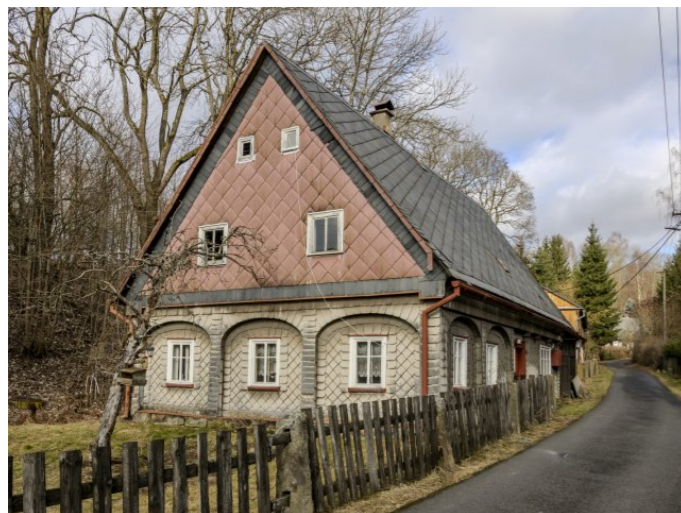
Brtníky č. ev. 28 - Pohled na objekt z jihu (Zdroj: S. Šulcová, 2024)
