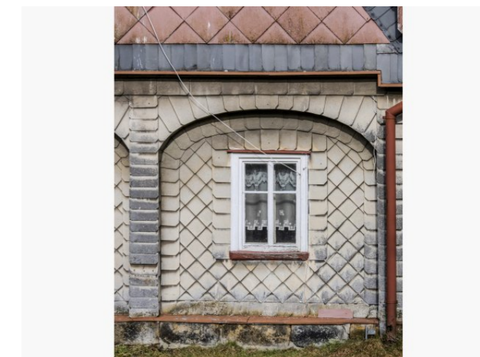
Brtníky č. ev. 28 - Detail podstávkového pole s okenním otvorem (Zdroj: S. Šulcová, 2024)
