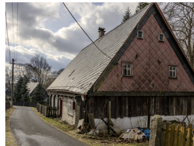
Brtníky č. ev. 28 - Pohled na objekt ze severovýchodu (Zdroj: S. Šulcová, 2024)
