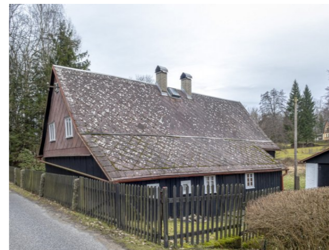
Brtníky č. ev. 30 - Pohled na objekt ze severozápadu (Zdroj: S. Šulcová, 2024)
