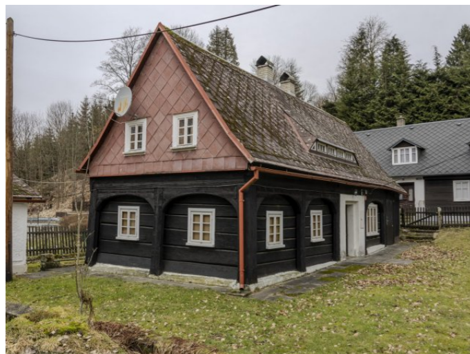
Brtníky č. ev. 30 - Pohled na objekt z jihovýchodu (Zdroj: S. Šulcová, 2024)
