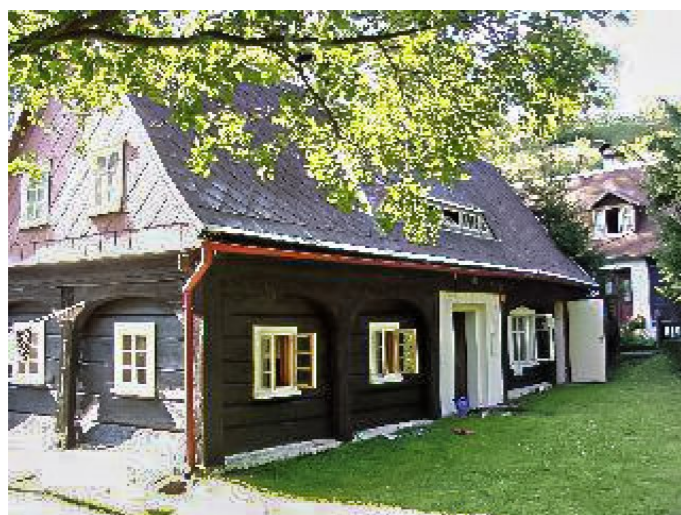
Brtníky č. ev. 30 - Pohled na objekt z jihovýchodu (Zdroj: TUR Šluknovsko, 2003)
