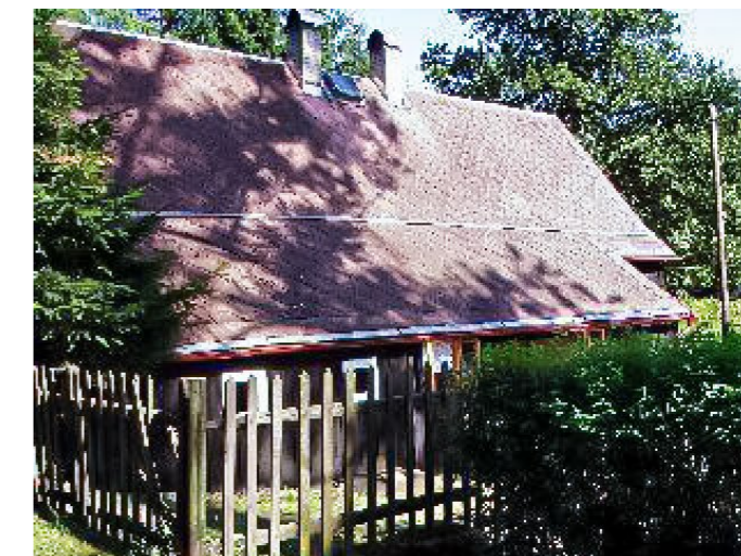
Brtníky č. ev. 30 - Pohled na objekt ze severozápadu (Zdroj: TUR Šluknovsko, 2003)
