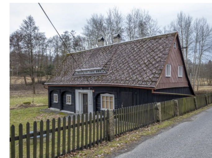
Brtníky č. ev. 30 - Pohled na objekt ze severovýchodu (Zdroj: S. Šulcová, 2024)
