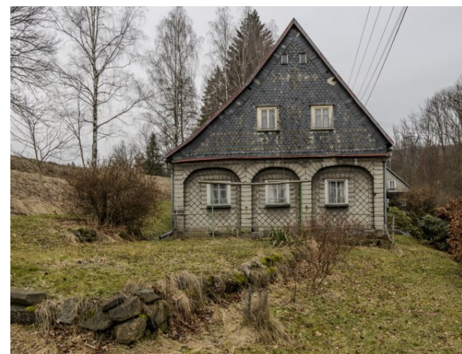
Brtníky č. ev. 32 - Pohled na objekt z jihovýchodu (Zdroj: S. Šulcová, 2024)
