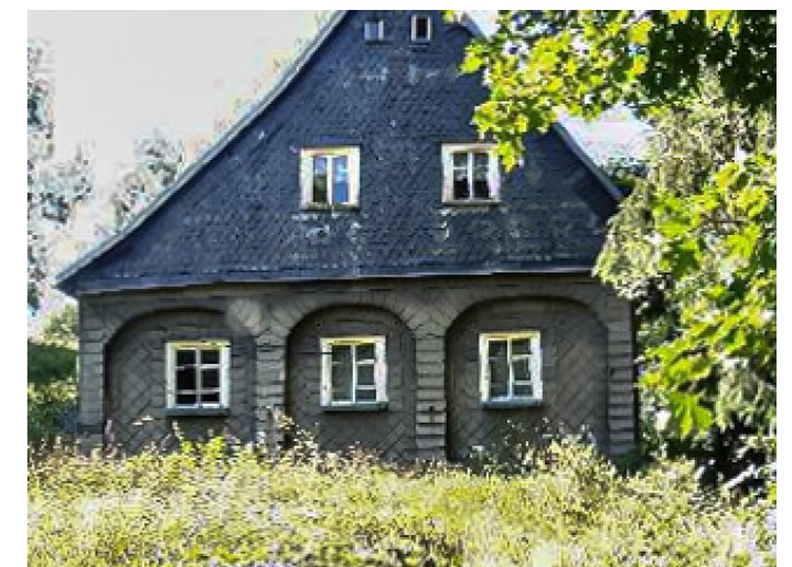
Brtníky č. ev. 32 - Pohled na objekt z jihovýchodu (Zdroj: TUR Šluknovsko, 2003)
