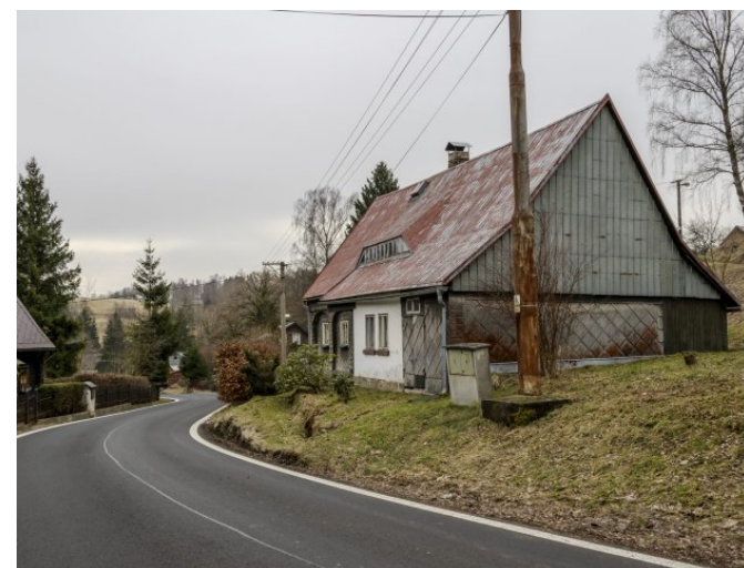
Brtníky č. ev. 32 - Pohled na objekt ze severozápadu (Zdroj: S. Šulcová, 2024)
