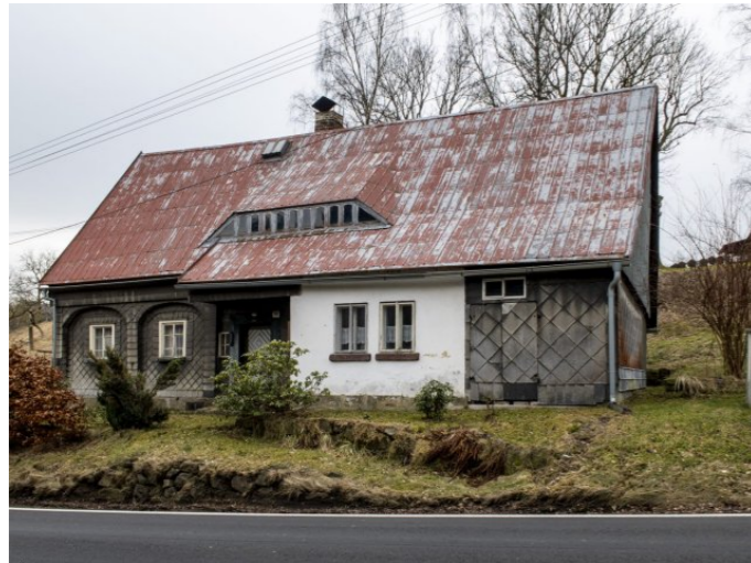
Brtníky č. ev. 32 - Pohled na objekt ze severozápadu (Zdroj: S. Šulcová, 2024)
