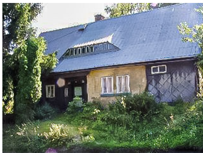
Brtníky č. ev. 32 - Pohled na objekt ze severovýchodu (Zdroj: TUR Šluknovsko, 2003)
