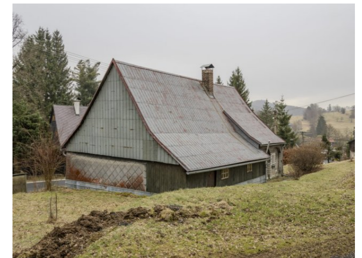
Brtníky č. ev. 32 - Pohled na objekt ze západu (Zdroj: S. Šulcová, 2024)
