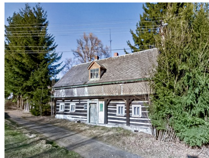
Brtníky č. ev. 36 - Pohled na objekt z jihozápadu (Zdroj: Panorama - MAPY.CZ. (2016). [Brtníky 36]. Online. Seznam.cz, 2024. Dostupné z: https://mapy.cz/zakladni?pano=1&q=brtn%C3%ADky [citováno 2024-03-20], 2012)
