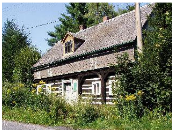
Brtníky č. ev. 36 - Pohled na objekt z jihozápadu (Zdroj: TUR Šluknovsko, 2003)
