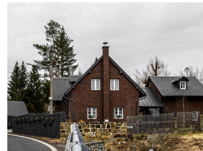
Brtníky č. ev. 36 - Pohled na novostavbu (Zdroj: S. Šulcová, 2024)
