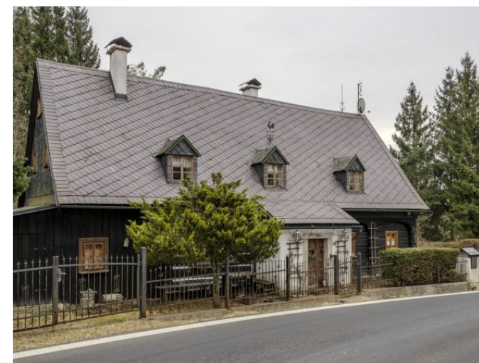
Brtníky č. ev. 39 - Pohled na objekt ze severozápadu (Zdroj: S. Šulcová, 2024)
