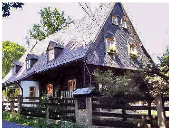
Brtníky č. ev. 39 - Pohled na objekt z jihu (Zdroj: TUR Šluknovsko, 2003)
