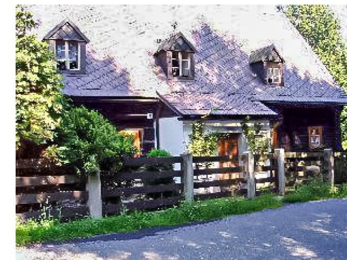
Brtníky č. ev. 39 - Pohled na objekt ze západu (Zdroj: TUR Šluknovsko, 2003)
