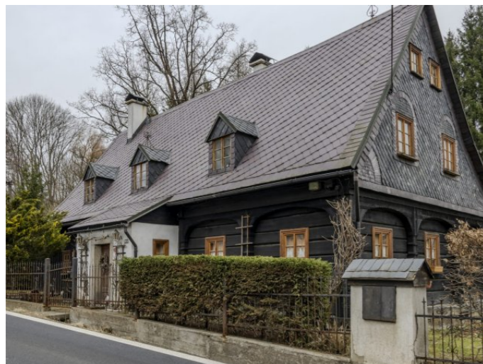
Brtníky č. ev. 39 - Pohled na objekt z jihu (Zdroj: S. Šulcová, 2024)
