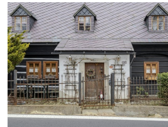
Brtníky č. ev. 39 - Pohled na vstupní část (Zdroj: S. Šulcová, 2024)
