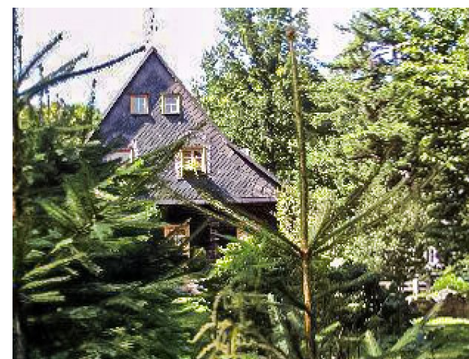
Brtníky č. ev. 39 - Pohled na objekt z jihovýchodu (Zdroj: TUR Šluknovsko, 2003)
