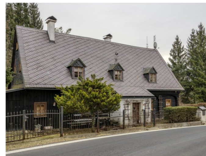
Brtníky č. ev. 39 - Pohled na objekt ze severozápadu (Zdroj: S. Šulcová, 2024)
