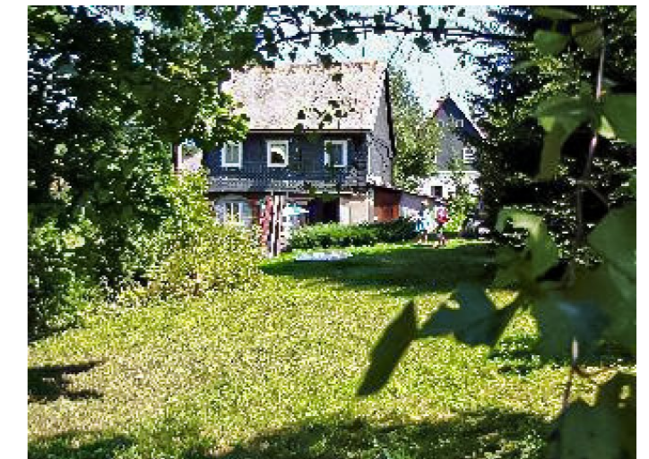
Brtníky č. ev. 45 - Pohled na objekt z jihu (Zdroj: TUR Šluknovsko, 2003)
