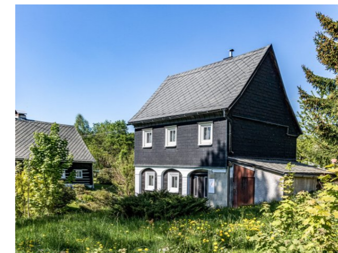
Brtníky č. ev. 45 - Pohled na objekt z jihovýchodu (Zdroj: S. Šulcová, 2018)
