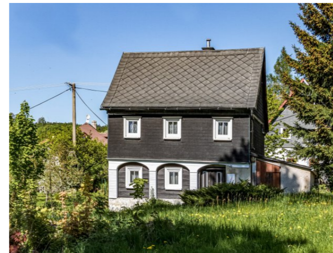
Brtníky č. ev. 45 - Pohled na objekt z jihu (Zdroj: S. Šulcová, 2018)
