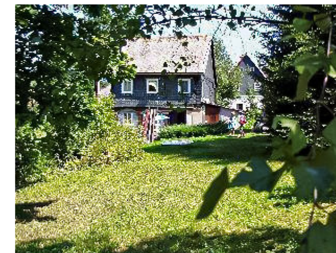
Brtníky č. ev. 45 - Pohled na objekt z jihu (Zdroj: TUR Šluknovsko, 2003)
