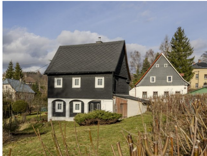
Brtníky č. ev. 45 - Pohled na objekt z jihu (Zdroj: S. Šulcová, 2024)
