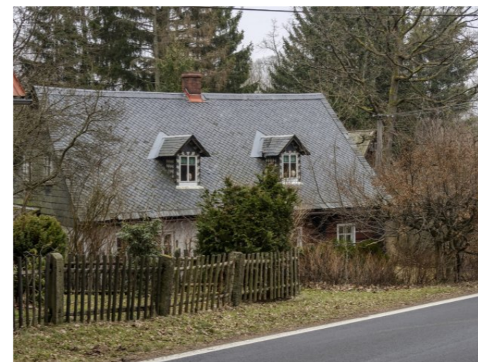
Brtníky č. ev. 48 - Pohled na objekt ze západu (Zdroj: S. Šulcová, 2024)
