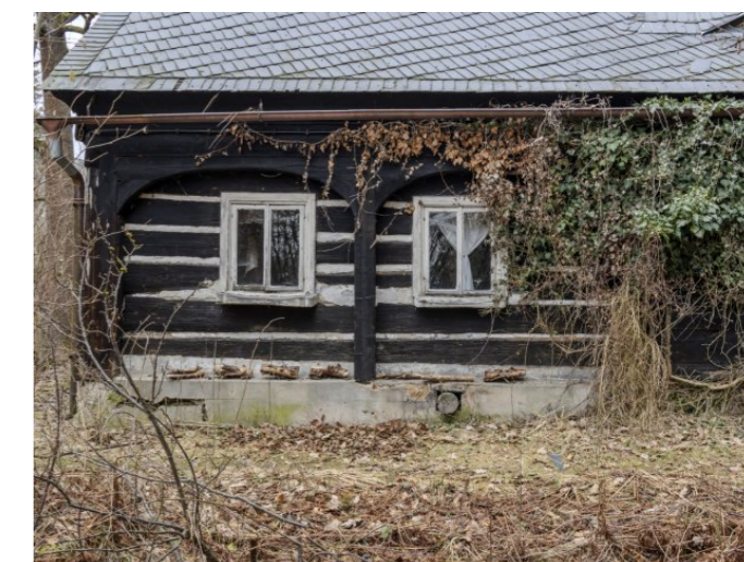
Brtníky č. ev. 49 - Pohled na objekt z jihovýchodu (Zdroj: S. Šulcová, 2024)
