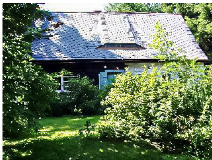
Brtníky č. ev. 49 - Pohled na objekt z jihovýchodu (Zdroj: TUR Šluknovsko, 2003)
