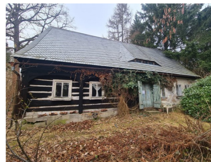
Brtníky č. ev. 49 - Pohled na objekt z jihovýchodu (Zdroj: S. Šulcová, 2024)
