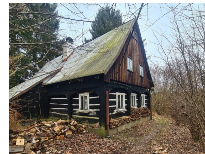
Brtníky č. ev. 49 - Pohled na objekt ze západu (Zdroj: S. Šulcová, 2024)
