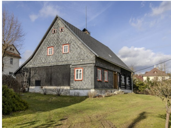
Brtníky č. ev. 53 - Pohled na objekt z jihu (Zdroj: S. Šulcová, 2024)
