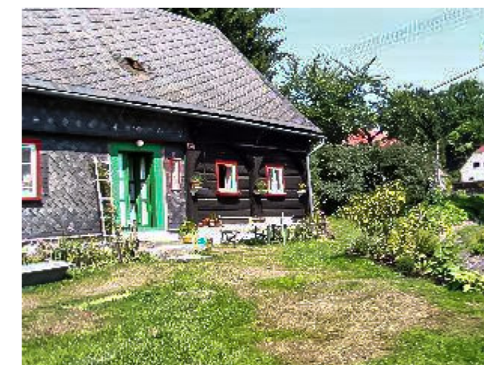
Brtníky č. ev. 53 - Pohled na objekt (Zdroj: TUR Šluknovsko, 2003)
