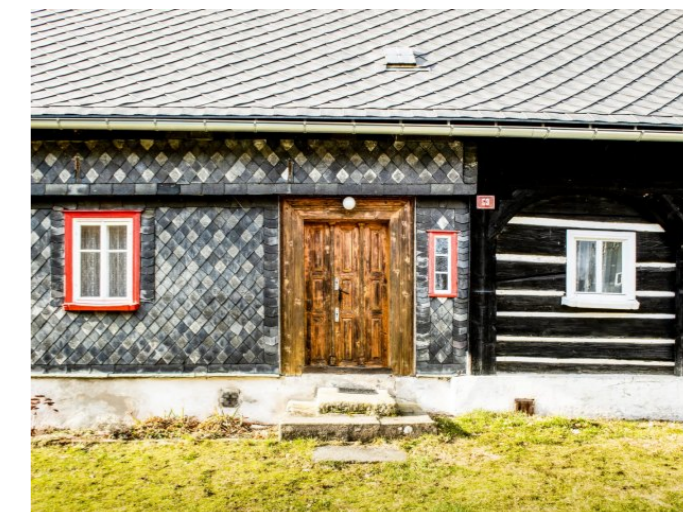
Brtníky č. ev. 53 - Detail vstupního portálu (Zdroj: S. Šulcová, 2024)
