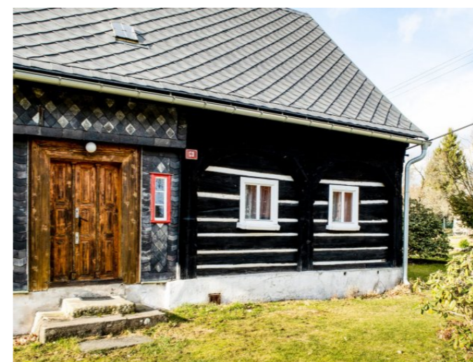
Brtníky č. ev. 53 - Detail vstupního portálu (Zdroj: S. Šulcová, 2024)
