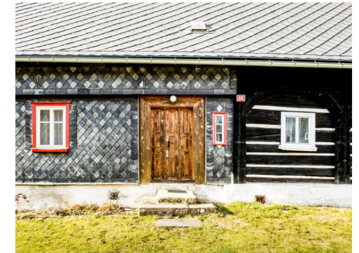
Brtníky č. ev. 53 - Detail vstupního portálu (Zdroj: S. Šulcová, 2024)
