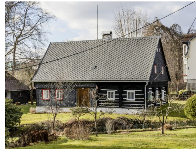
Brtníky č. ev. 53 - Pohled na objekt z jihovýchodu (Zdroj: S. Šulcová, 2024)
