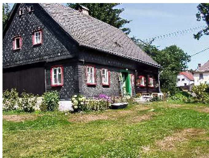
Brtníky č. ev. 53 - Pohled na objekt z jihu (Zdroj: TUR Šluknovsko, 2003)
